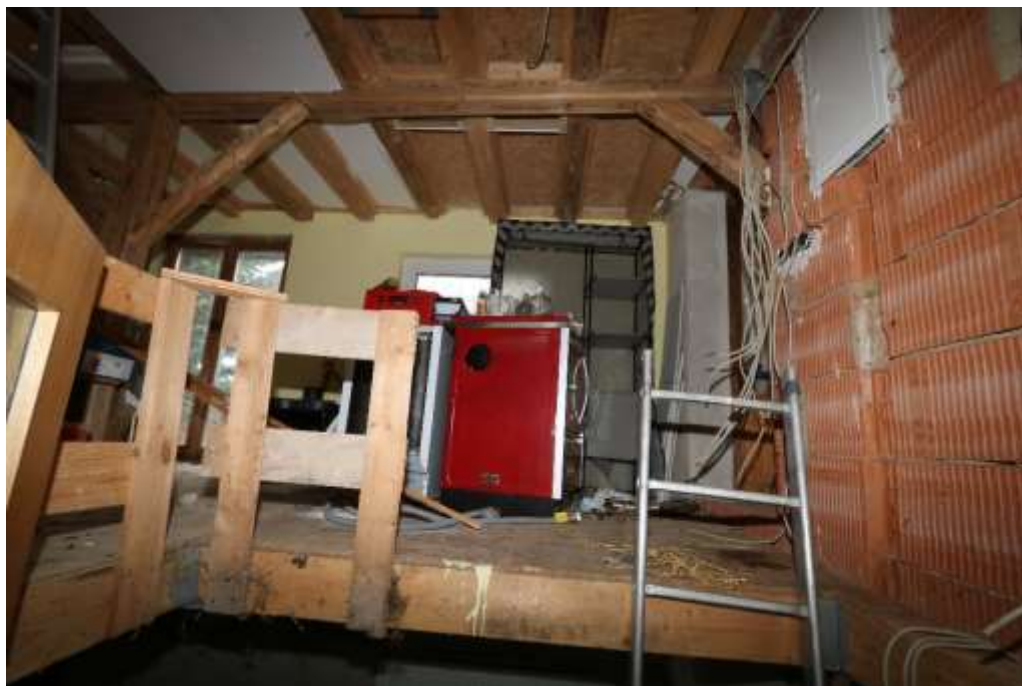
Scheune, Ausbau nicht fertig gestellt
