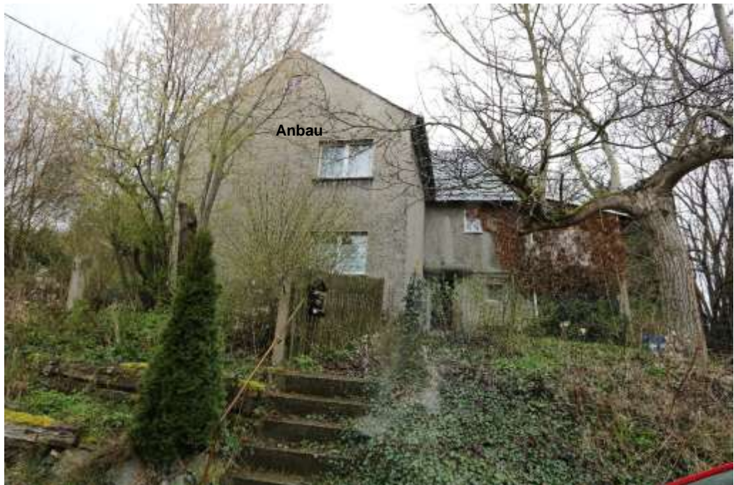
Wohnhaus mit Anbau, NO-Ansicht
