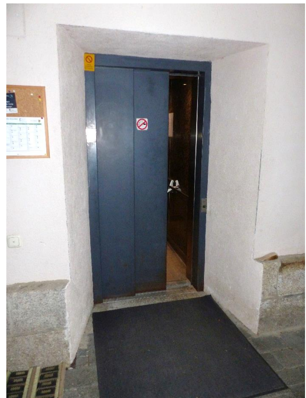
Fahrstuhl-Zugang im Erdgeschoss
