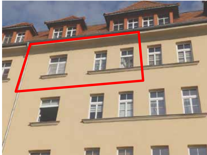
Bild 5: Detailansicht der Straßenseite des Mehrfamilienhauses (mit Wohnung Nr. 7)
