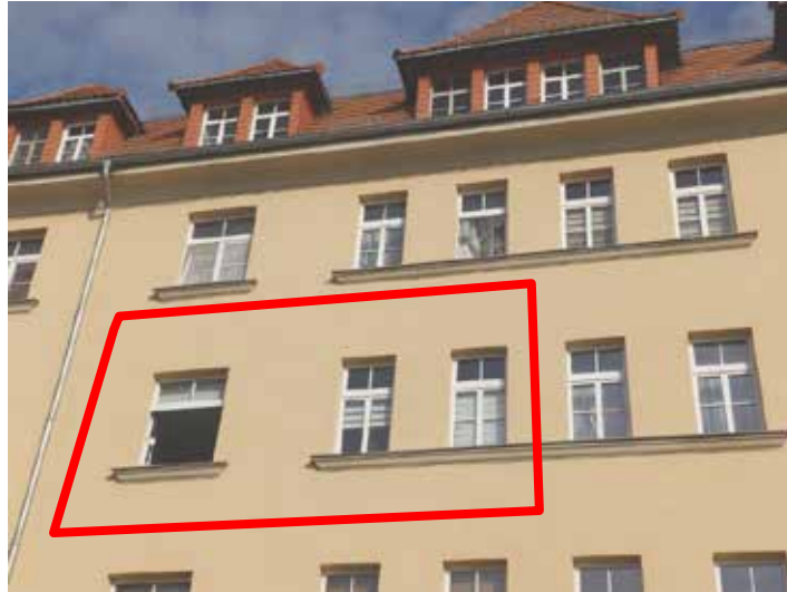
Bild 5: Detailansicht der Straßenseite des Mehrfamilienhauses (mit Wohnung Nr. 5)
