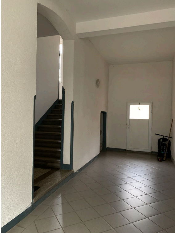
Abb. 04 Ansicht Hausflur im Erdgeschoss mit Blick zur Ausgangstür zum Garten und Geschosstreppe zu Obergeschoss, links vom Hausflur
