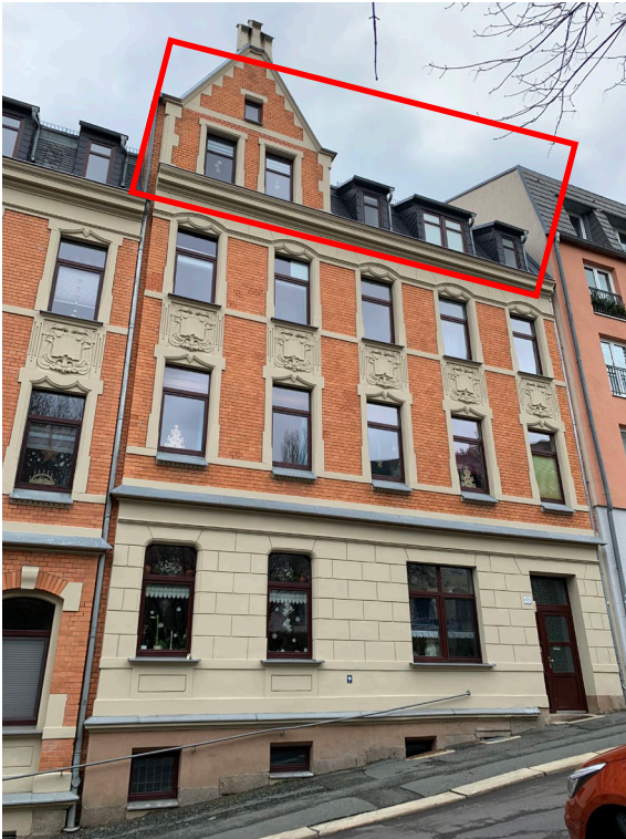
Abb. 01 Straßenansicht des Wohngebäudes mit angrenzender Bebauung und Lage der Wohnung Nr. 4 im Dachgeschoss, Südwesten
