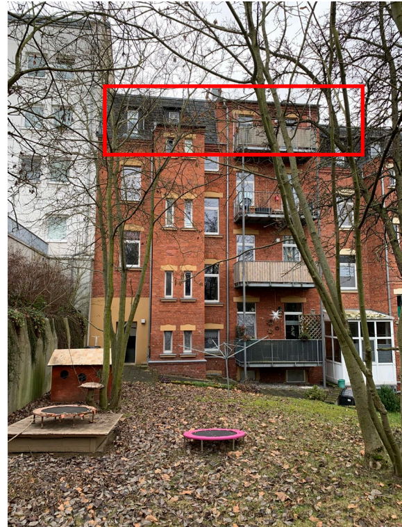
Abb. 02 Gebäuderückansicht und Lage der Wohnung Nr. 4 im Dachgeschoss, Nordosten
