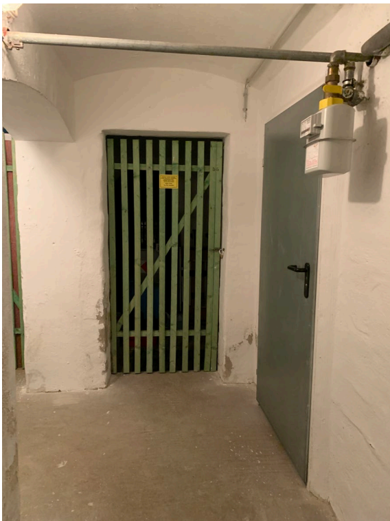
Abb. 15 Kellergeschoss, Blick auf den Zugang zum zugeordneten Kellerraum Nr. 4, bezeichnet mit „DG“
