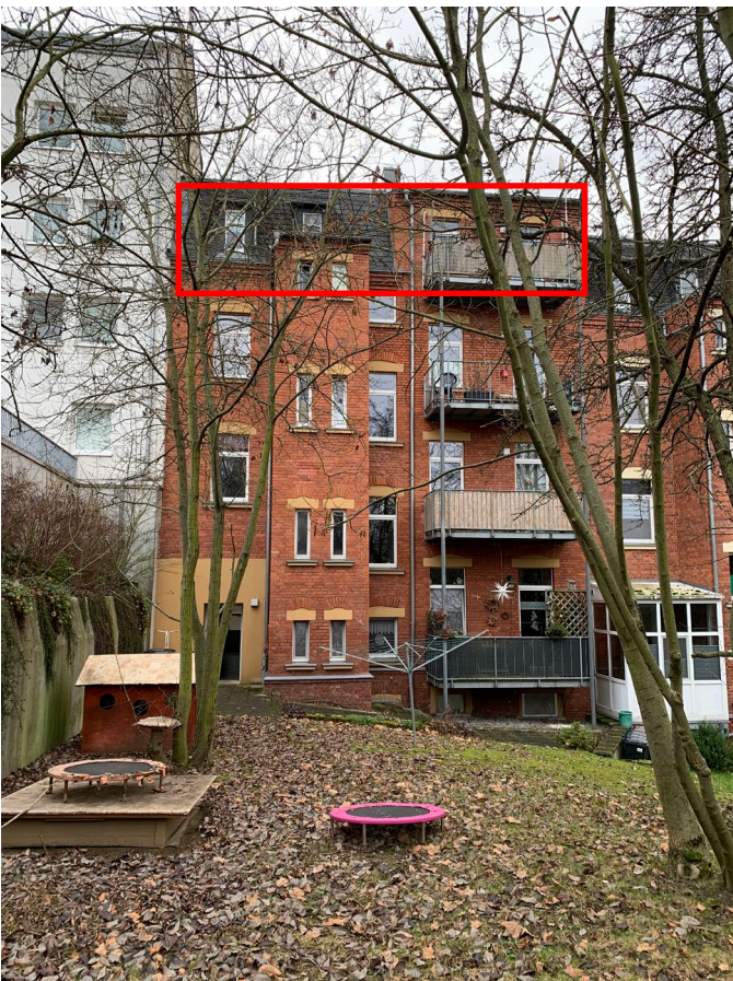
Abb. 02 Gebäuderückansicht und Lage der Wohnung Nr. 4 im Dachgeschoss, Nordosten
