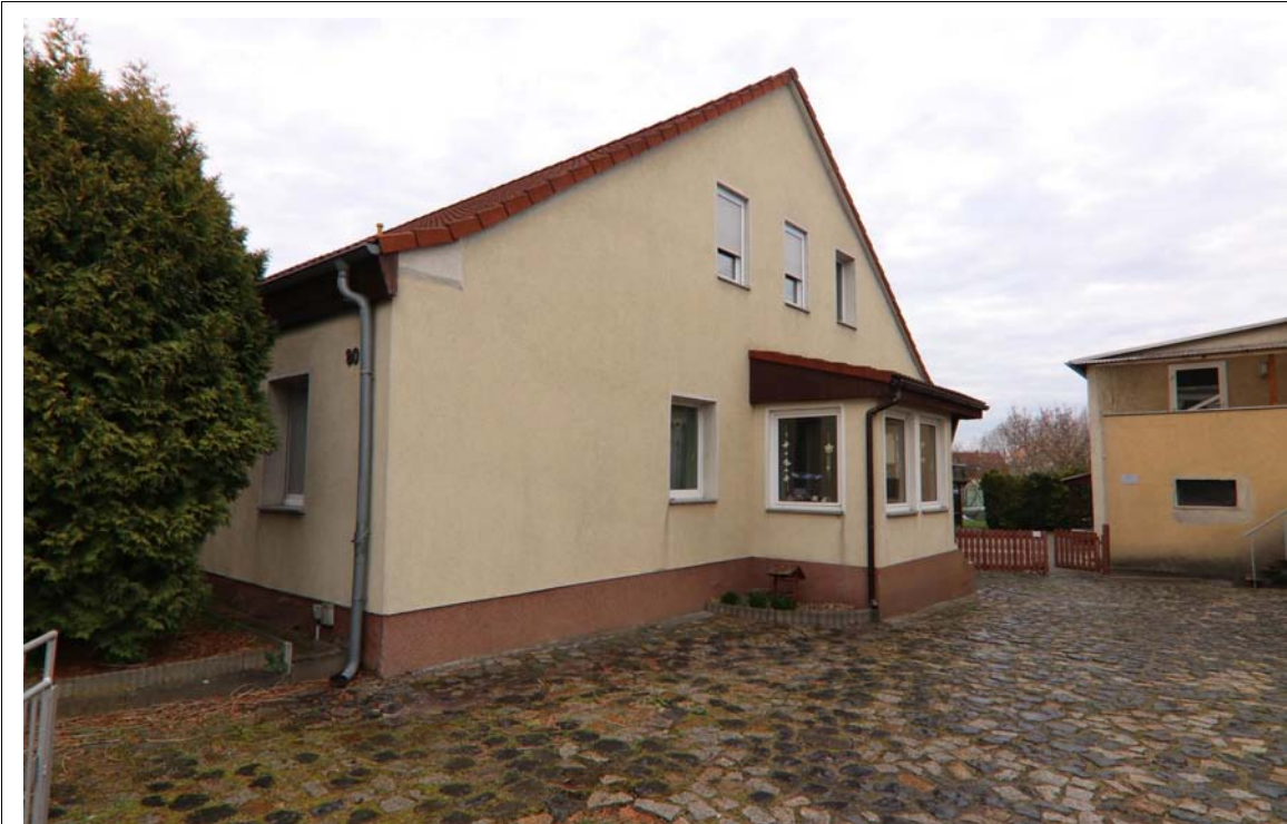
Blick von der Jahnstraße auf die Giebelseite der Doppelhaushälfte Jahnstraße 80 in Weißwasser
