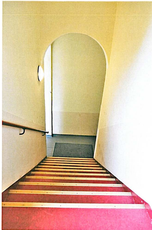
Treppenhaus EG mit Zugang zum Hausdurchgang
