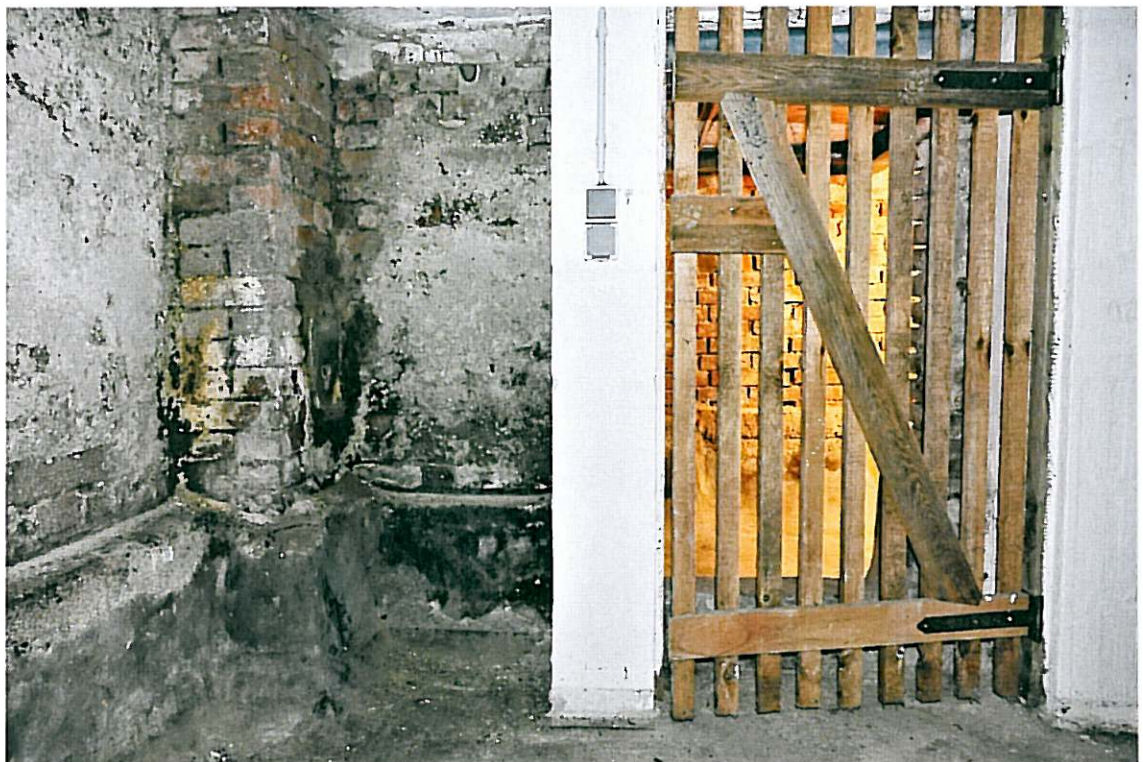
KG, Lagereinheit Nr. 11 mit Schornstein und Zugangstüre
