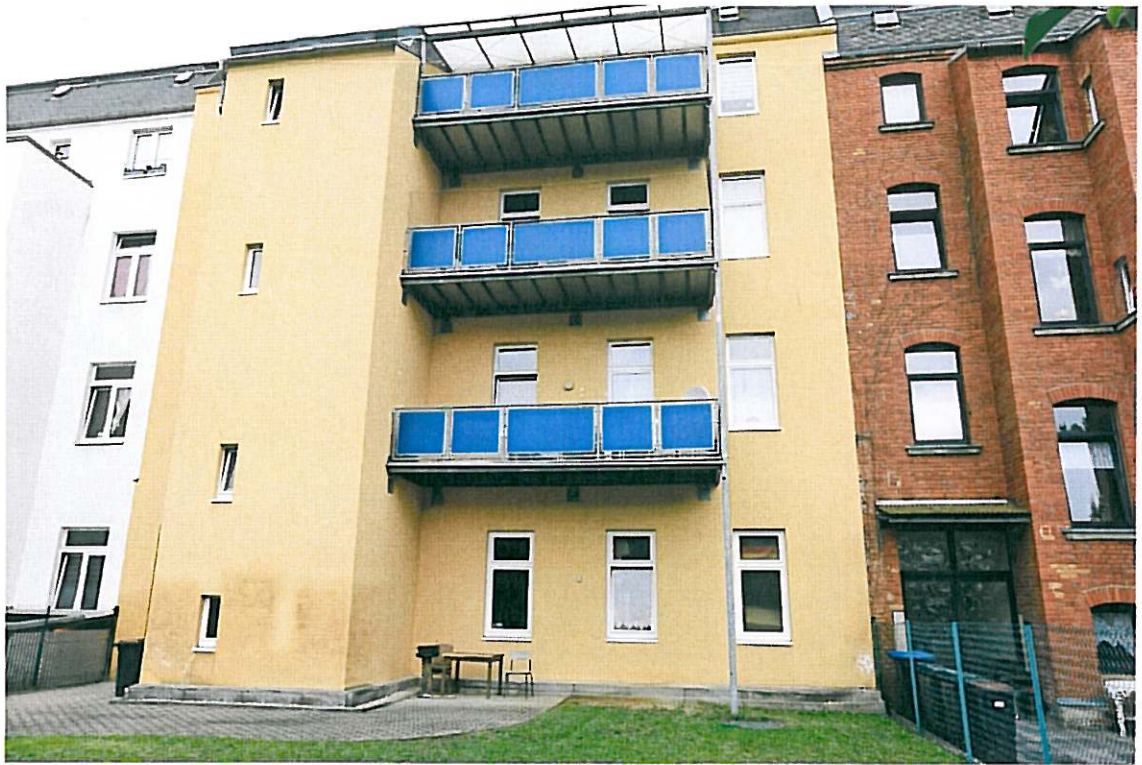
Wohn-/Geschäftshaus (nordöstlicher Bereich) mit Kellerfensterlichtschacht der Lager- einheit Nr. 11 im KG unterhalb des linken EG-Fensters (unter dem Tisch), SO-Ansicht
