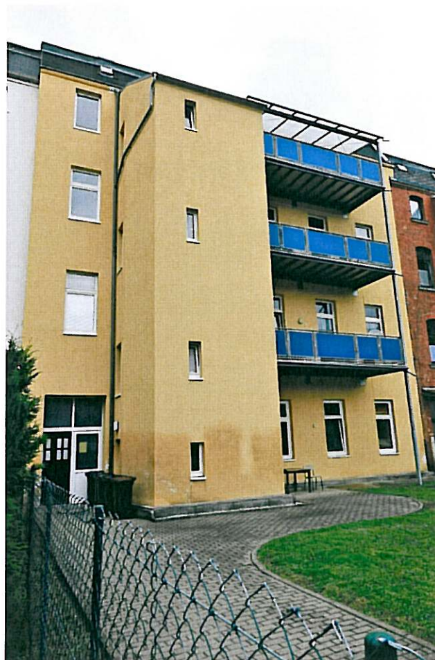
Wohn-/Geschäftshaus (südwestlicher Bereich) mit Hauszugang, Südansicht
