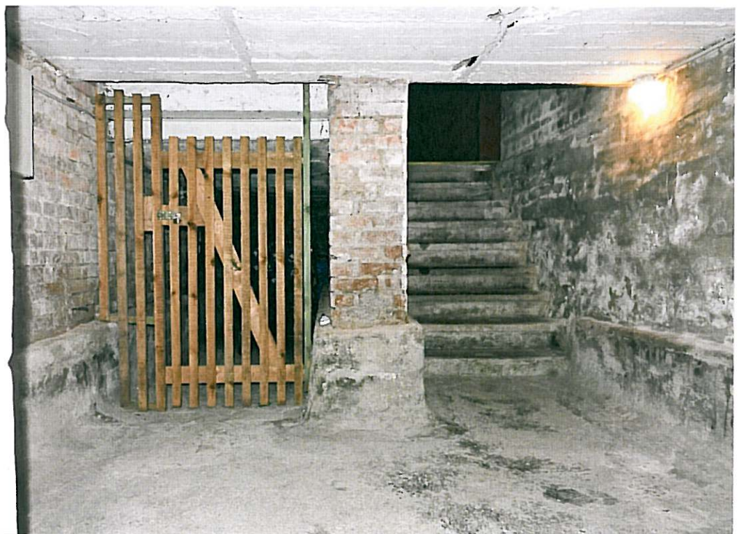
KG, Flur mit Kellertreppe
