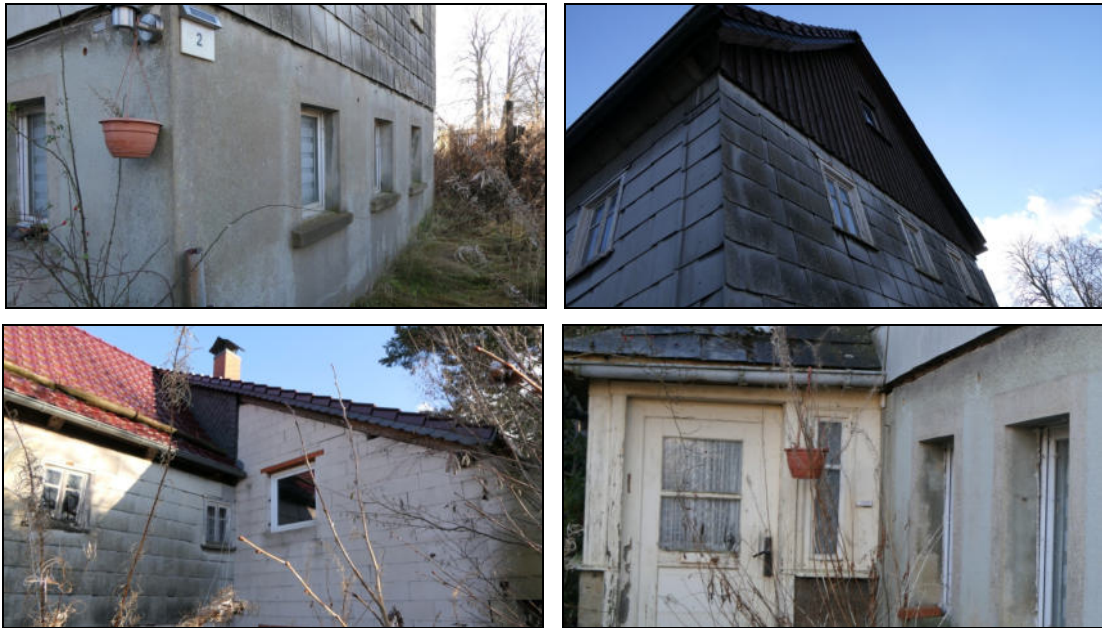
Abbildung 7: Detailansichten: Fertigstellungsbedarf und Schäden an der Fassadenbekleidung
