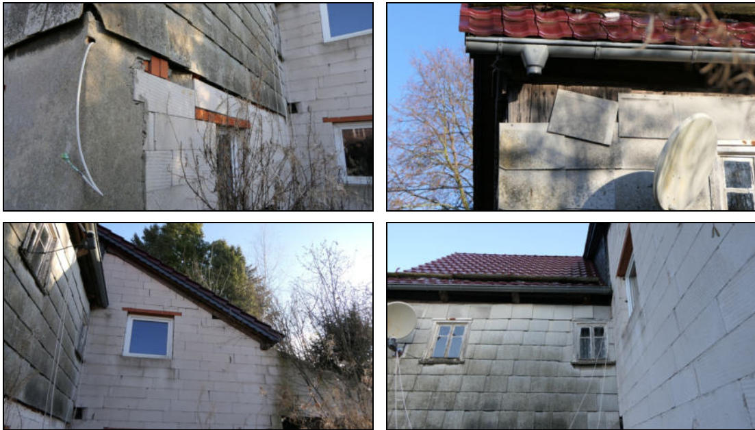
Abbildung 9: Detailansichten: Fertigstellungsbedarf und Schäden an der Fassadenbekleidung
