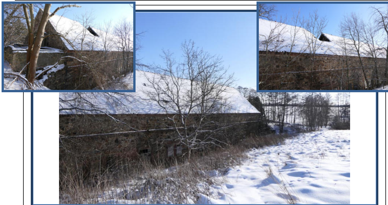
Abbildung 5: West-Ansicht (Rückansicht); Dach tlw. bereits eingestürzt; tlw. sehr starke Hanglage; verwilderte Außenanlage
