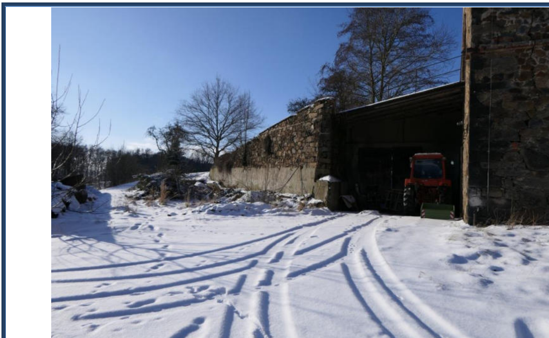
Abbildung 15: Verwilderte und beschädigte Außenanlagen im südlichen Grundstücksteil; Tennenauffahrt; links das benachbarte Flurstück 4
