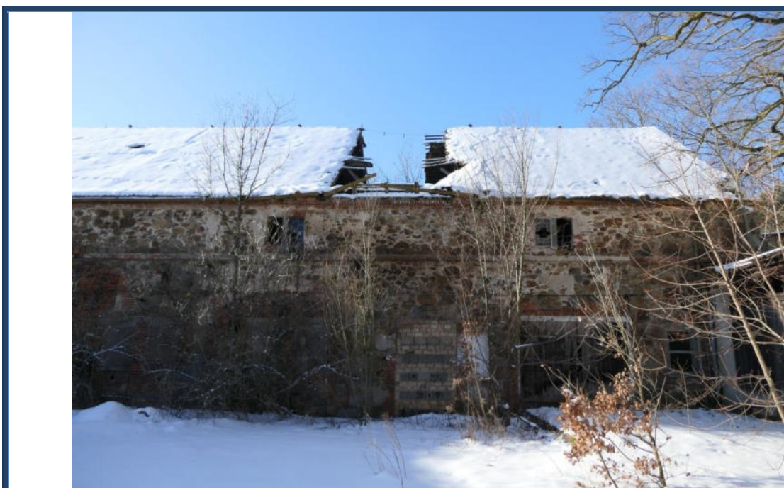
Abbildung 8: Ost-Ansicht (Vorderansicht); Dach tlw. bereits eingestürzt; im Vordergrund das benachbarte Flurstück 2/1
