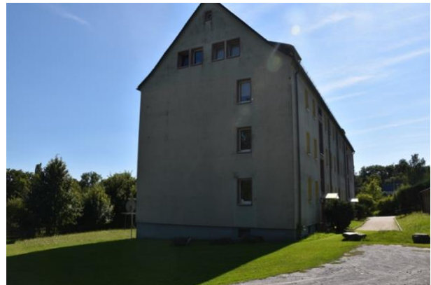
Foto 6: Ostansicht des Gebäudes
