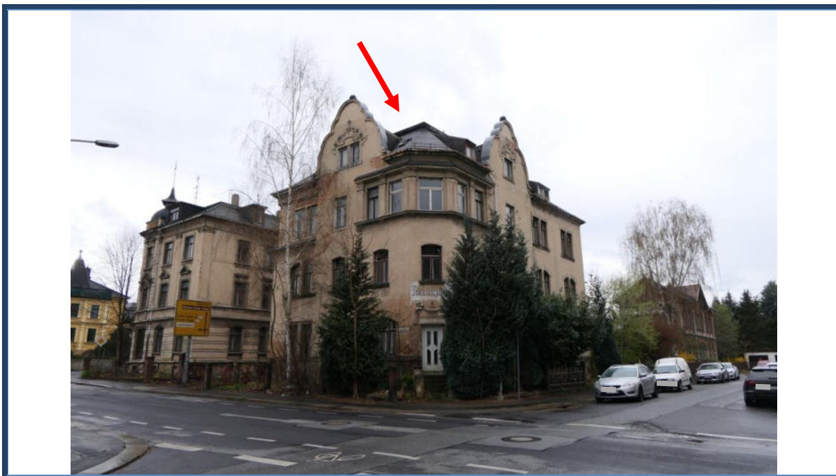
Abbildung 1: Straßenansicht (Nord-Ost-Ansicht); Kreuzungsbereich der Humboldtstraße und der Friedrich-Schneider-Straße; stark verwilderte und beschädigte Außenanlagen; umliegende Bebauung
