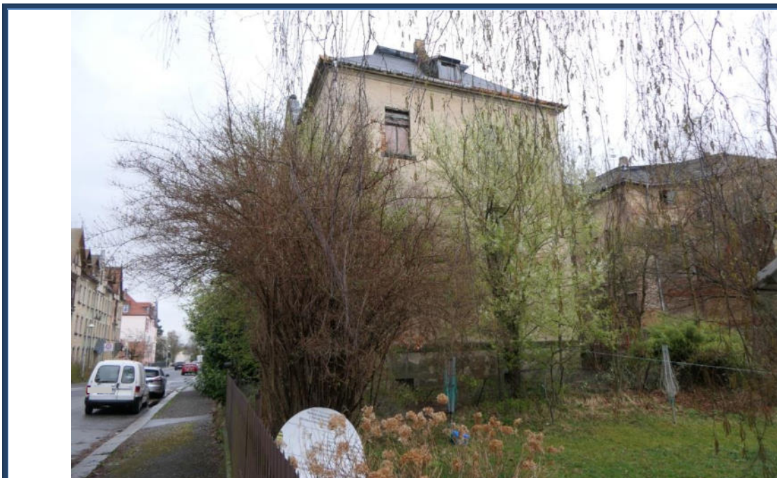
Abbildung 5: Rückansicht (West-Ansicht); verwilderte und beschädigte Außenanlagen; umliegende Bebauung
