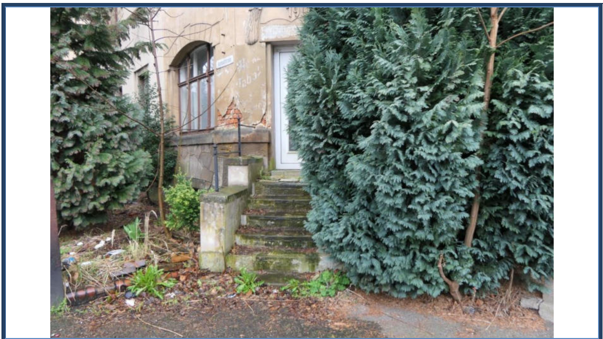
Abbildung 14: Stark verwilderte und beschädigt Außenanlagen
