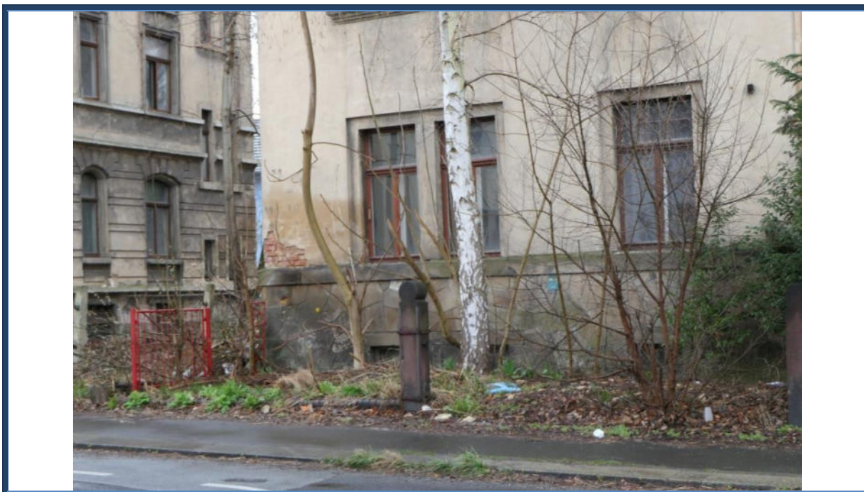
Abbildung 15: Stark verwilderte und beschädigte Außenanlagen; umliegende Bebauung
