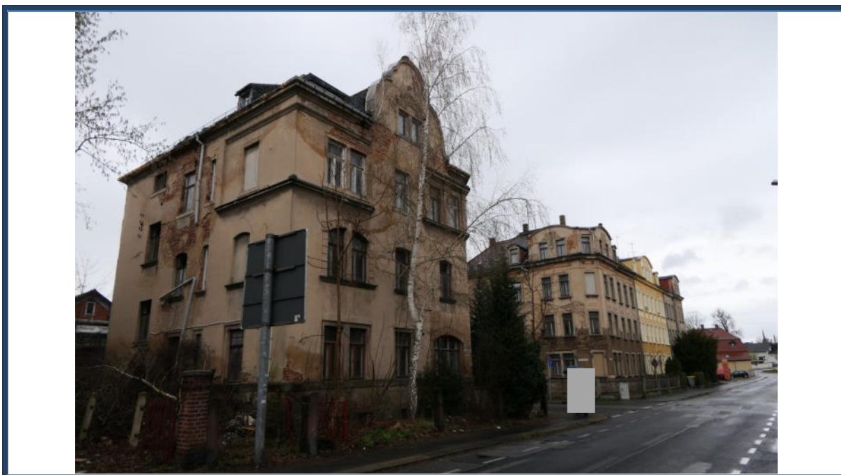
Abbildung 2: Straßenansicht (Süd-Ost Ansicht); stark verwilderte und beschädigte Außenanlagen; umliegende Bebauung
