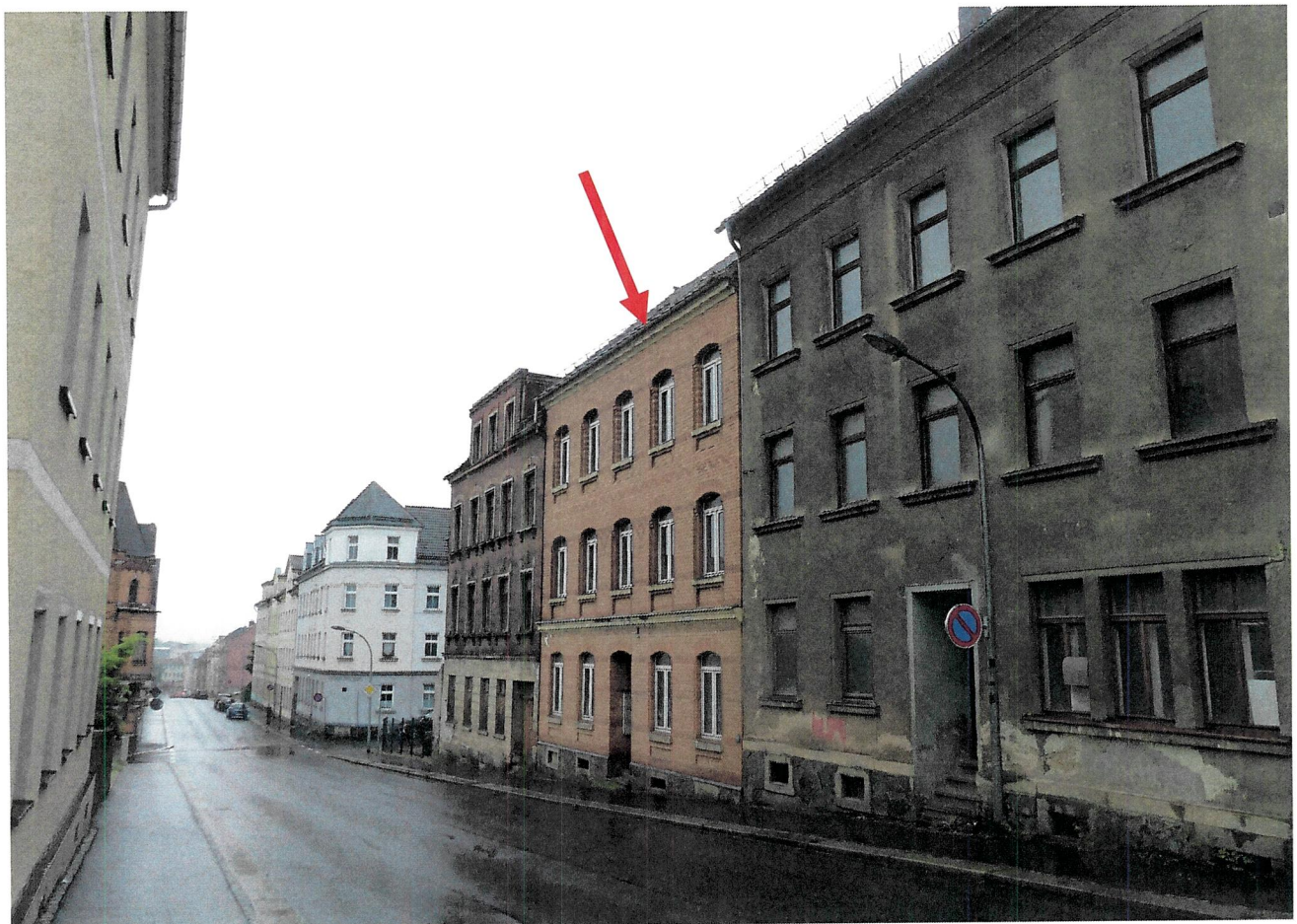
Nord-Ost-Ansicht mit Nachbarbebauung
