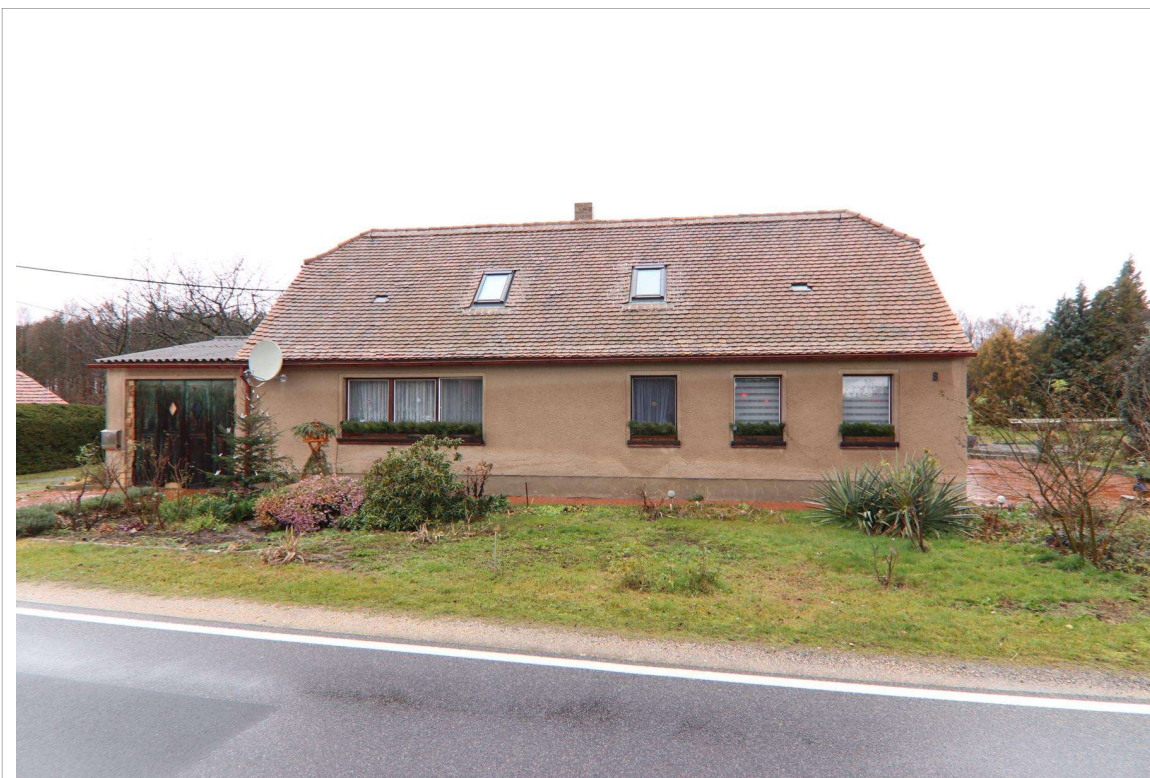
Blick in nördliche Richtung auf die südliche Fassade des Einfamilienhauses an der Diehsaer Straße 8 in Hohendubrau OT Thräna.
