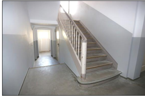
Blick in das Erdgeschoss des Treppenhauses mit Zugang in den Hinterhof sowie den Keller.
