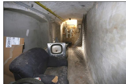
Blick in den Kellerraum, welcher der Bewertungswohnung W 8 zugeordnet ist.
