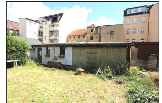
Blick auf ein Schuppengebäude an der nord-östlichen Grundstücksgrenze.
