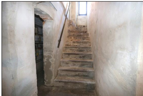
Blick auf den Treppenabgang in das Kellergeschoss.
