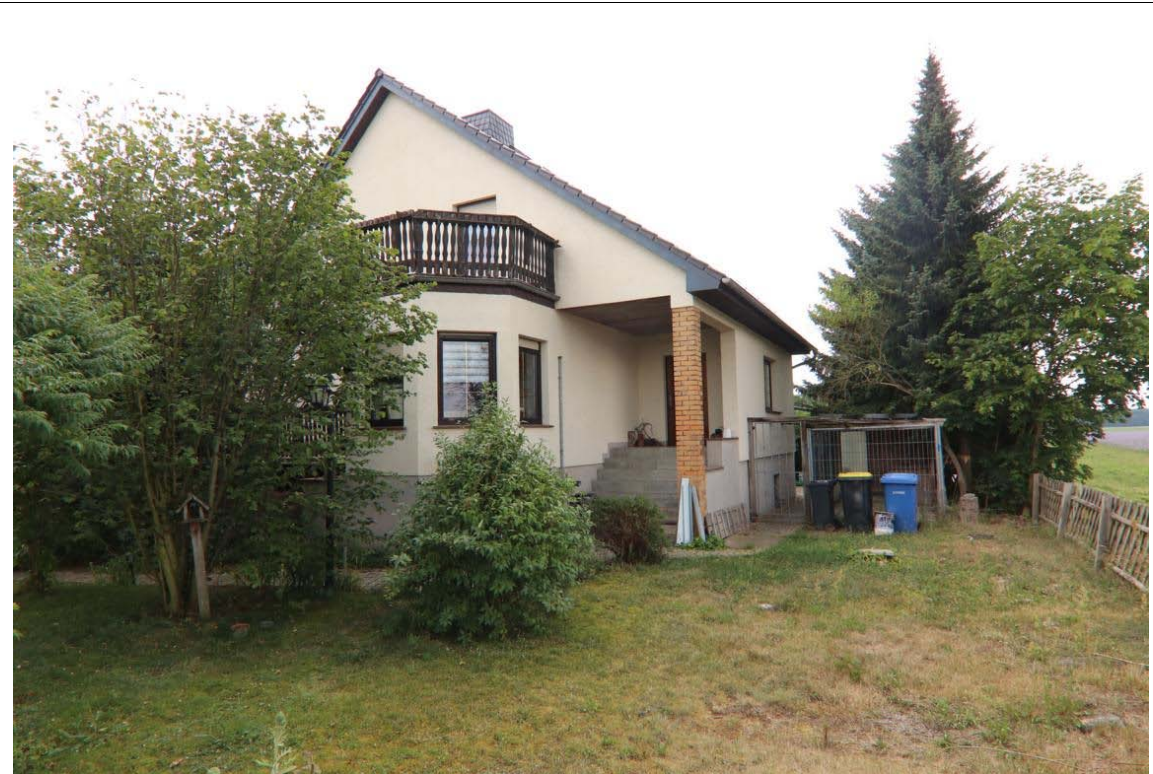
Blick in westliche Richtung entlang der nördlichen Grenze des zu bewertenden Wohngrundstücks, das aus den Flurstücken 1147/8 und 1147/16 besteht.
