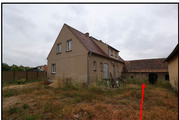
Nord-Ost-Ansicht des Wohnhauses mit angebautem Nebengebäude
