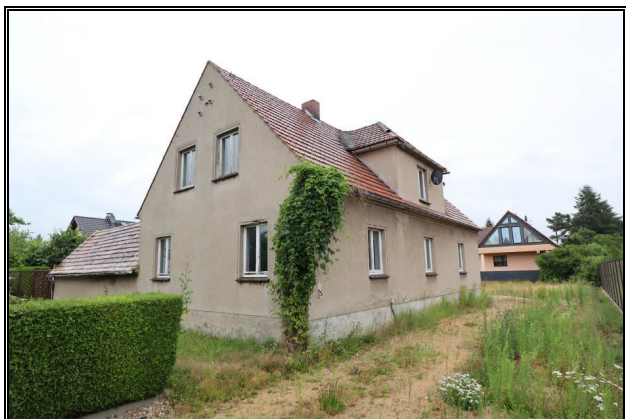
Süd-West-Ansicht des Wohnhauses
