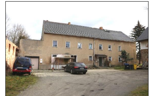
Blick auf die westlich ausgerichtete Fassade des Wohngebäudes mit den Gebäudeeingängen
