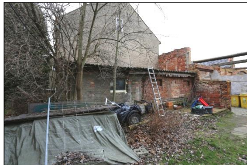
Blick auf die Fassaden des eingeschossigen Garagenanbaus an das Wohnhaus
