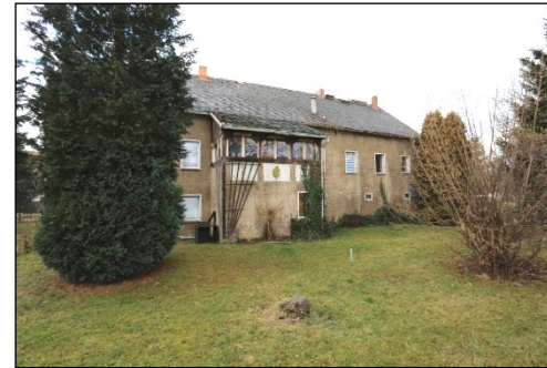
Blick aus östlicher Richtung auf das Wohngebäude mit Anbau
