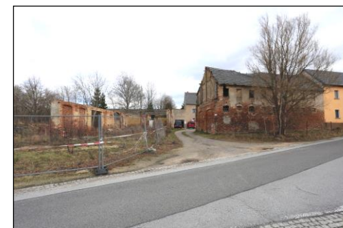
Blick aus westlicher Richtung auf die Zufahrt zum Bewertungsgrundstück in zweiter Reihe, welche nicht rechtlich gesichert ist
