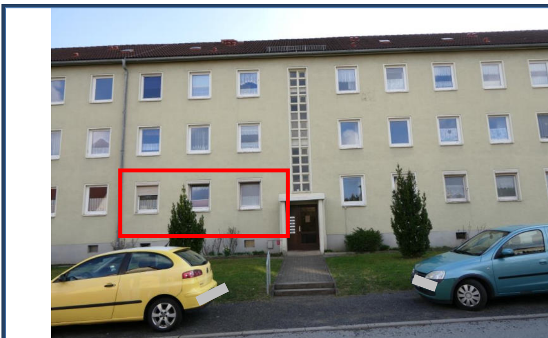
Abbildung 6: Vorderansicht (Süd-Ansicht) ; Eingangsbereich; Lage des zu bewertenden Wohnungseigentums Nr. 7; Außenanlagen
