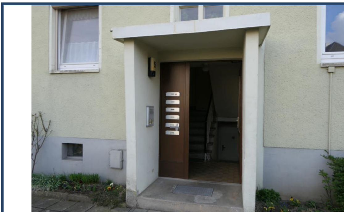
Abbildung 8: Hauseingangsbereich an der Gebäudenordseite; Außenanlagen
