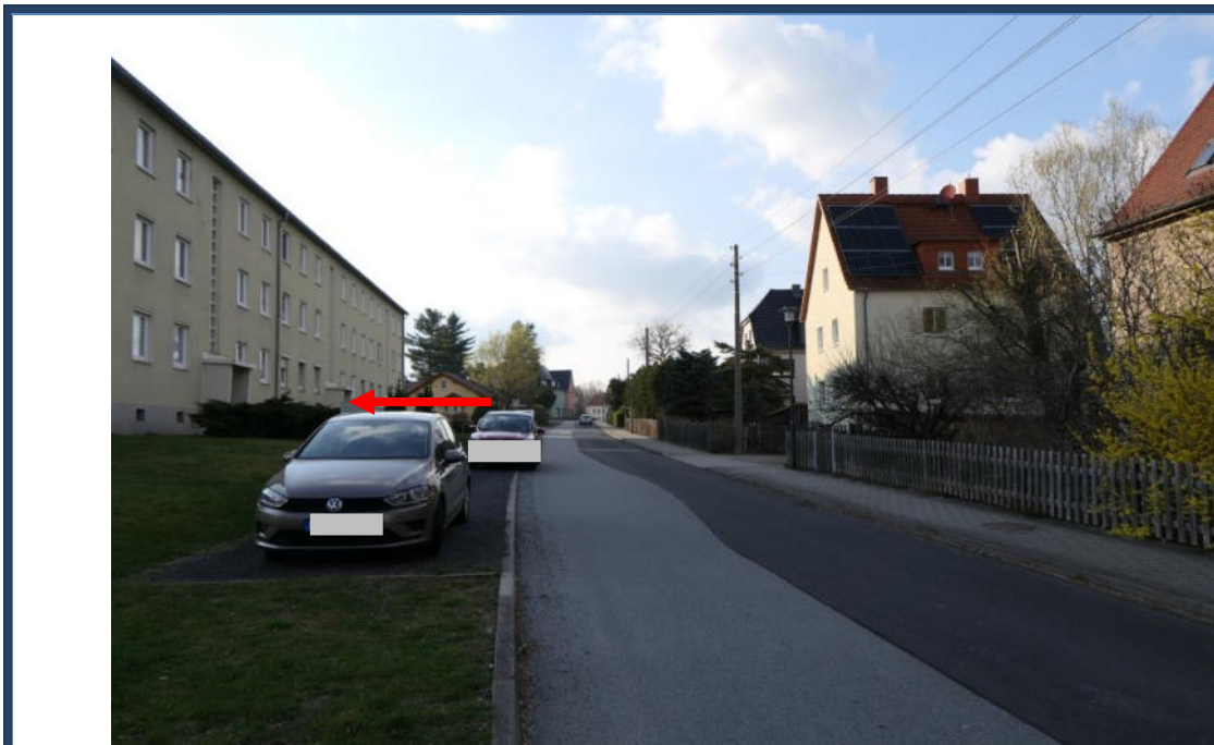
Abbildung 27: Blick in die Clara-Zetkin-Straße in westliche Richtung; links das Bewertungsobjekt; umliegende Bebauung
