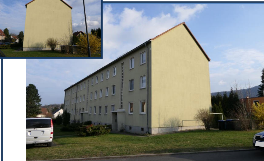
Abbildung 2: Vorder- und Seitenansicht (Nord-West-Ansicht); Außenanlagen; umliegende Bebauung
