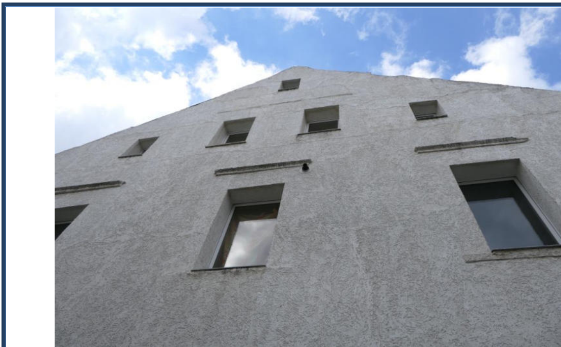
Abbildung 5: Vordergebäude: Giebelansicht (Südseite)
