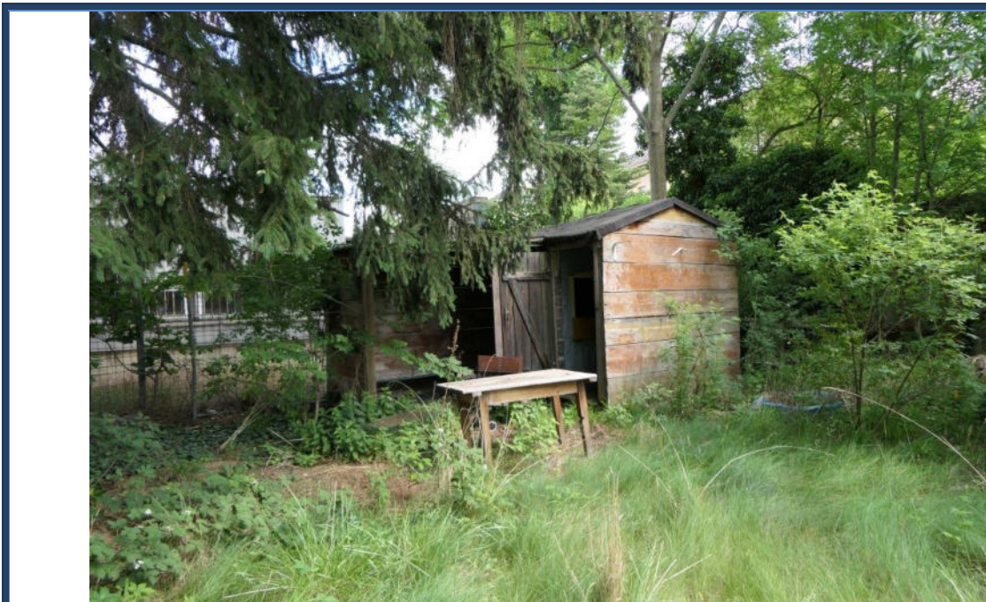
Abbildung 24: Verwilderte Außenanlagen im östlichen Grundstücksbereich
