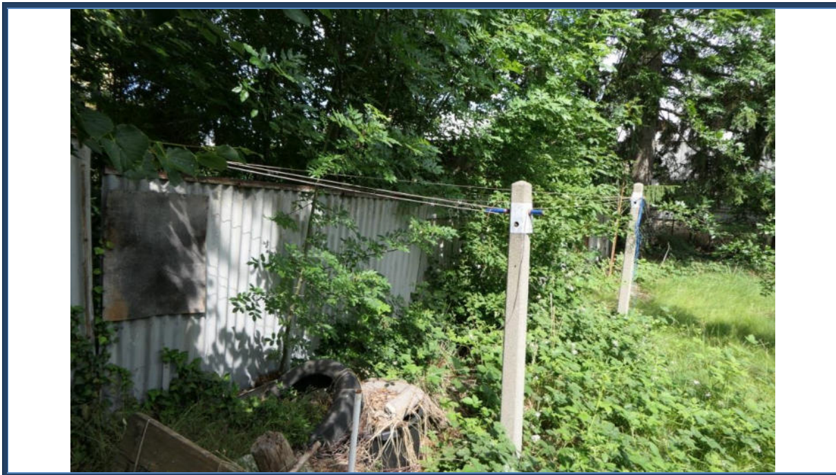
Abbildung 27: Verwilderte Außenanlagen im nordöstlichen Grundstücksbereich
