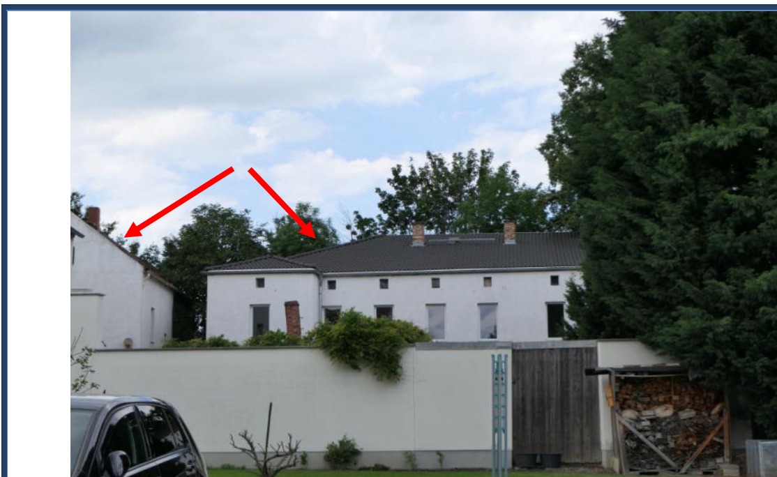
Abbildung 21: Blick von der Weststraße in nördliche Richtung; links das Vordergebäude, mittig das Hintergebäude; im Vordergrund benachbarte Bebauung
