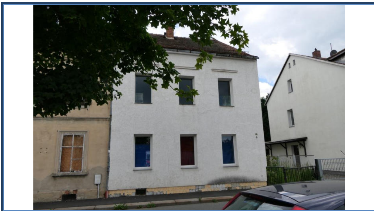
Abbildung 4: Vordergebäude: Straßenansicht (West-Ansicht); rechts der Einfahrtsbereich; angrenzende und umliegende Bebauung
