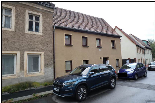
Nord-Ansicht des Bewertungsobjekts
