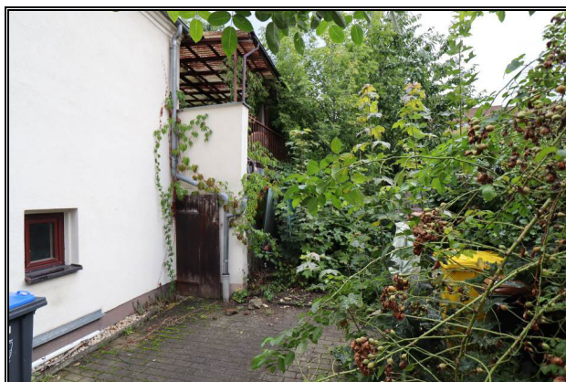
West-Ansicht des Nebengebäudes mit aufgelagerter Terrasse
