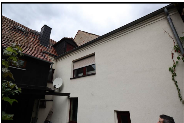
Süd-Ansicht des Wohnhausanbaus
