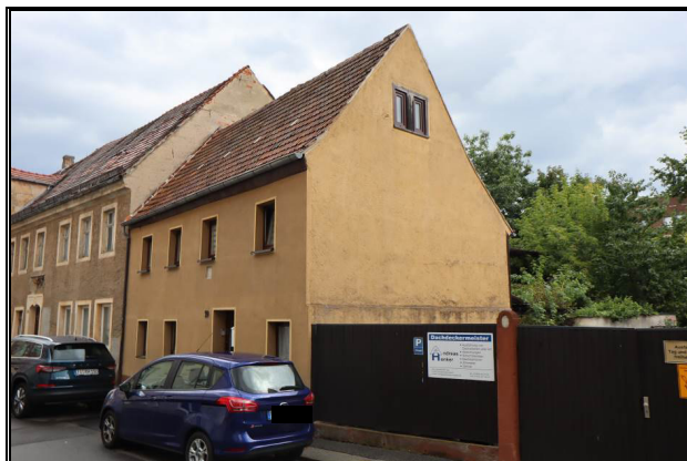
Süd-West-Ansicht des Wohnhauses
