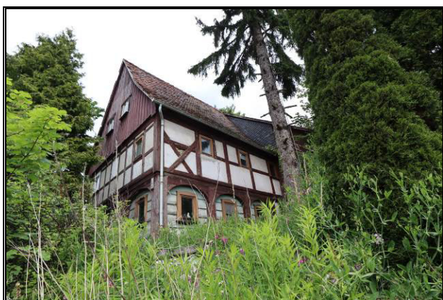
Süd-Ost-Ansicht des Bewertungsobjekts
