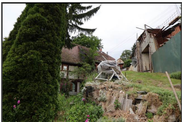
Teil der Weg-Stützmauer (Süd-Ost-Ansicht)
