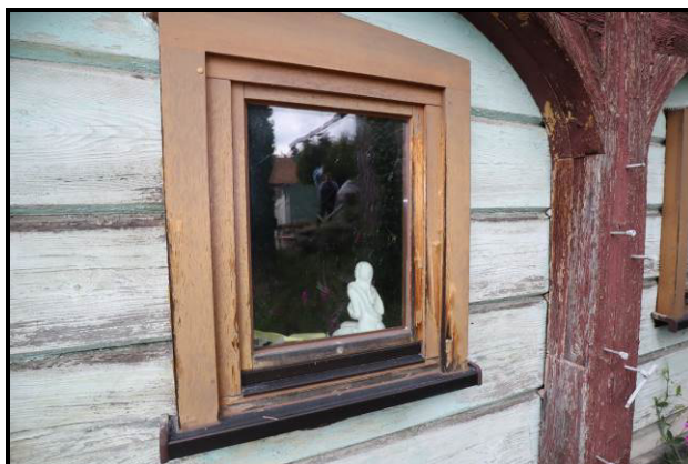
Detailansicht zu erneuerndes Fenster
