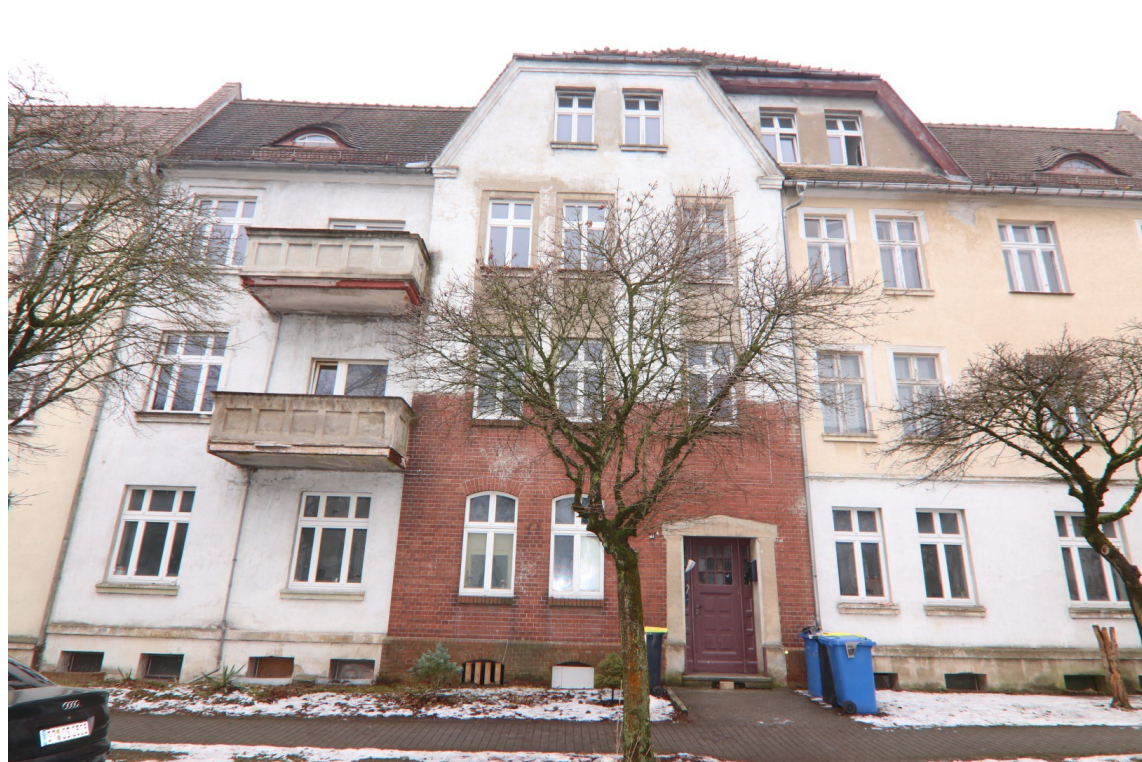
Blick von der Gartenstraße in Weißwasser in südliche Richtung auf die Fassade des Mehrfamilienhauses mit der Hausnummer 18, in dem sich die Wohnung W 1824 befindet.
