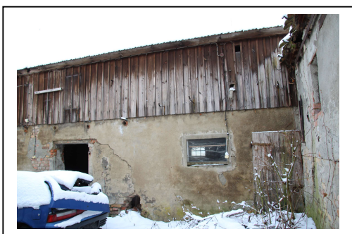
Ansicht des ehem. Stallgebäudes 4 vom Hof.
