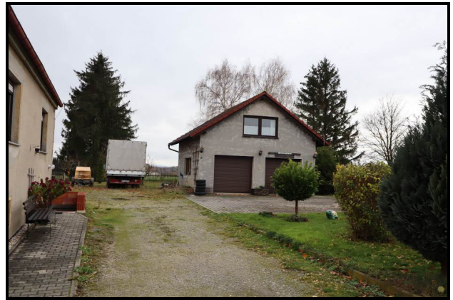
Nord-Ansicht der Doppelgarage
