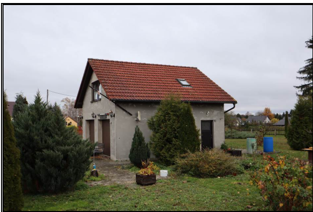
West-Ansicht der Doppelgarage
