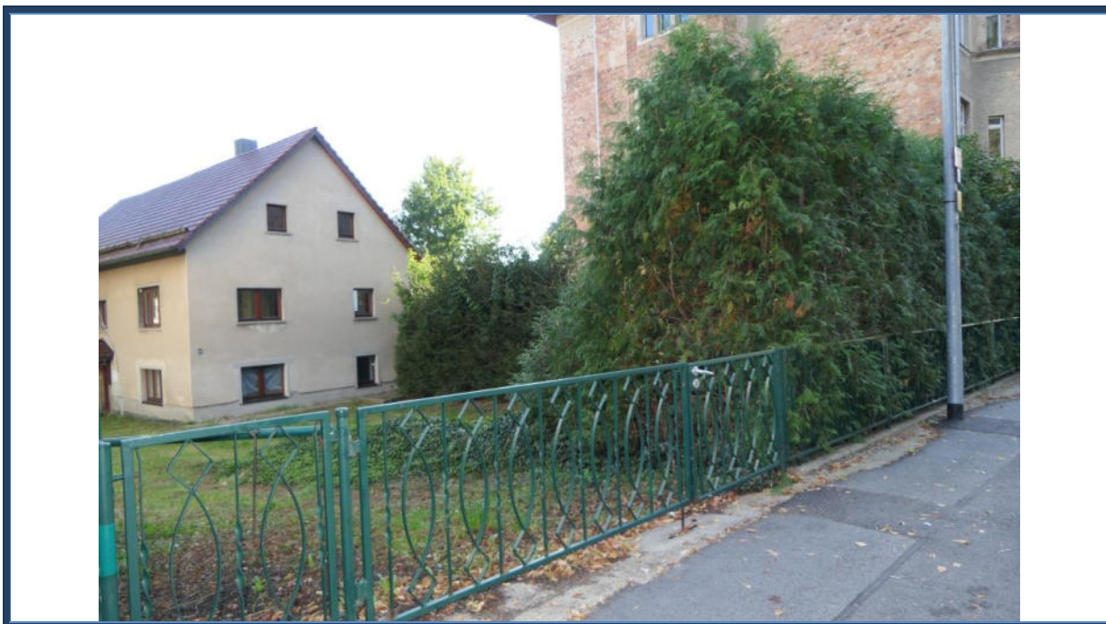
Abbildung 20: Einfahrtsbereich vom Külzufer; Außenanlagen; umliegende Bebauung
