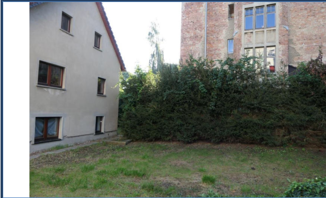
Abbildung 17: Außenanlagen im südöstlichen Grundstücksbereich; umliegende Bebauung
