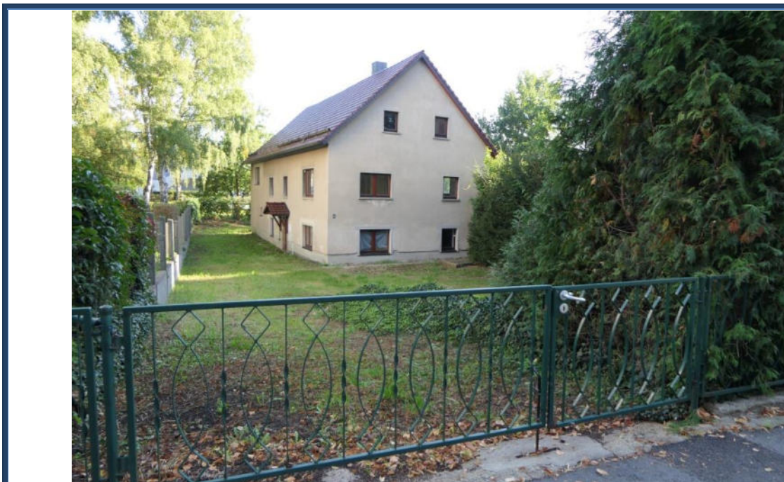
Abbildung 21: Blick in nördliche Richtung vom Külzufer; Einfahrtbereich; Außenanlagen
