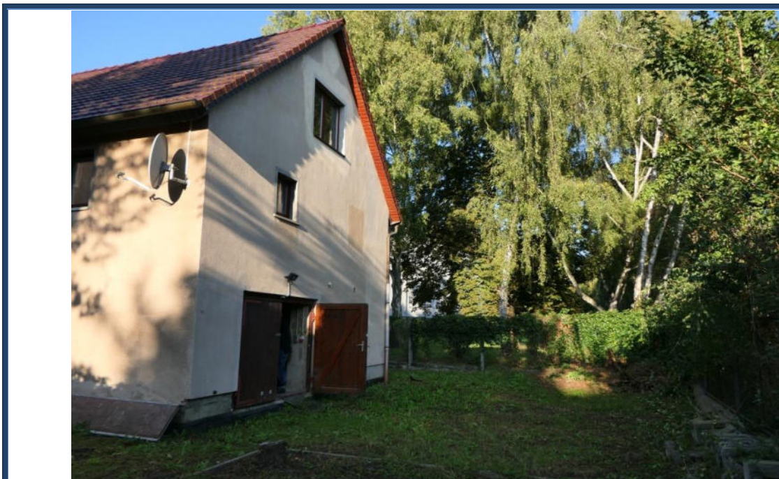
Abbildung 13: Außenanlagen im nördlichen Grundstücksbereich; rückseitiger Eingang zum Heizungs- und Lagerraum
