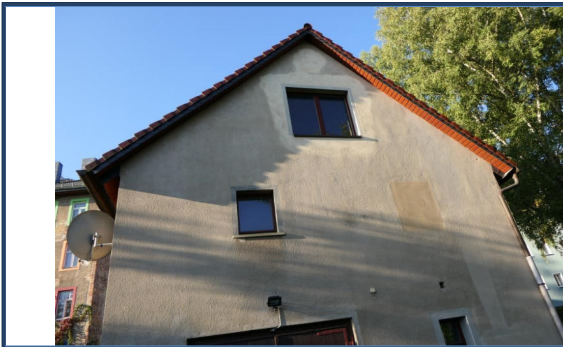
Abbildung 4: Nord-Ansicht; umliegende Bebauung
