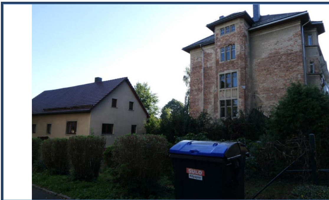
Abbildung 22: Blick vom Külzufer; links das Bewertungsobjekt; umliegende Bebauung
