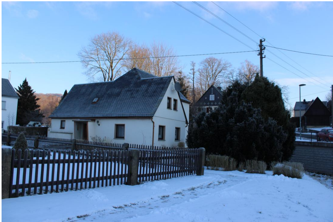
Foto Nr. 1: Südwest-Ansicht
