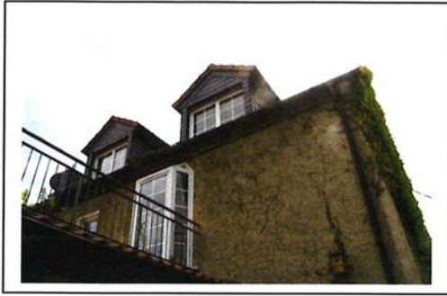
Ansicht der hinteren Gebäudeteilfront.
