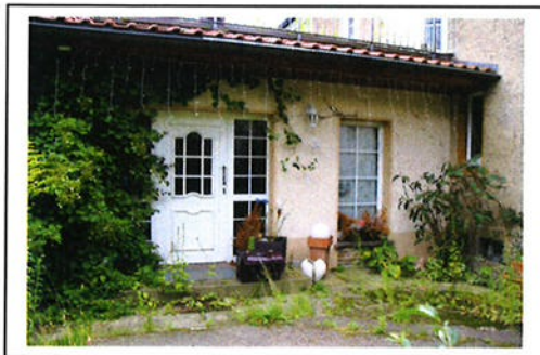
Ansicht des Eingangsvorhauses vom Hof.
