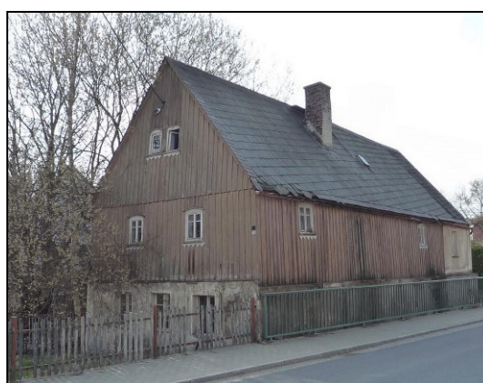
Gebäudeansicht aus dem Jahr 2012
