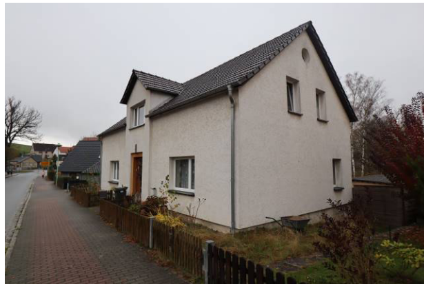
Nord-Ansicht des Bewertungsobjekts von der Czornebohstraße
