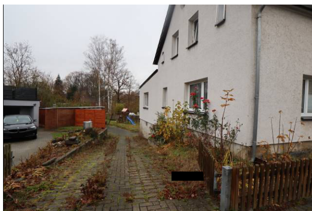
Süd-Ost-Ansicht des Bewertungsobjekts und der Grundstückszufahrt
