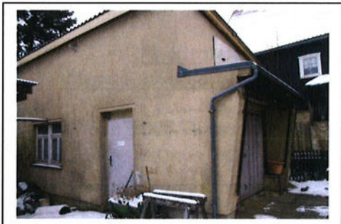
Ansicht des Garagengebäudes vom Hof.
