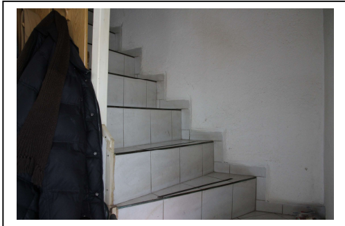
Ansicht des Treppenhauses in das Obergeschoss, Stufenhöhen außer Norm.
