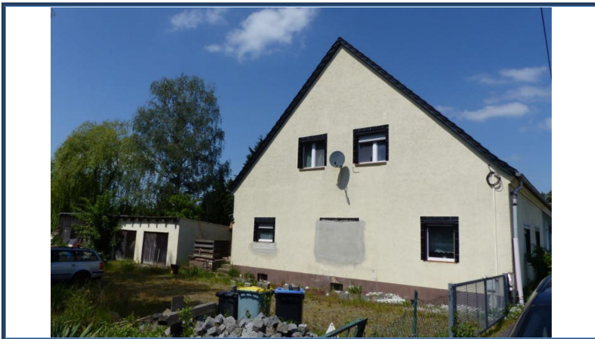
Abbildung 5: Süd-Ansicht (Giebelansicht); links die massive Doppelgarage; verwilderte und beschädigte Außenanlagen
