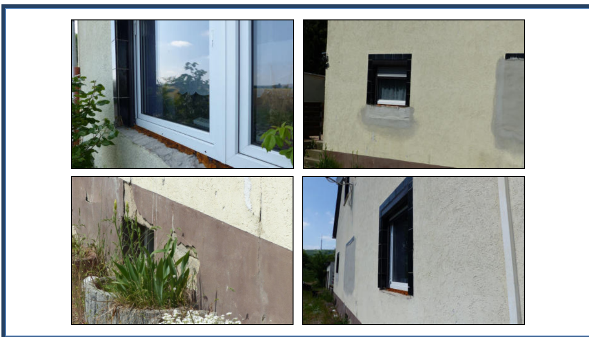
Abbildung 9: Detailansichten der Fassade; tlw. Fertigstellungsbedarf hinsichtlich Fenstereinbau- und Putz-/Malerarbeiten
