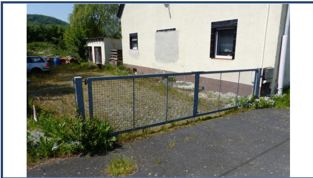
Abbildung 7: Einfahrts-/Eingangsbereich; verwilderte und beschädigte Außenanlagen; Unratablagerungen; im Hintergrund der „Löbauer Berg“
