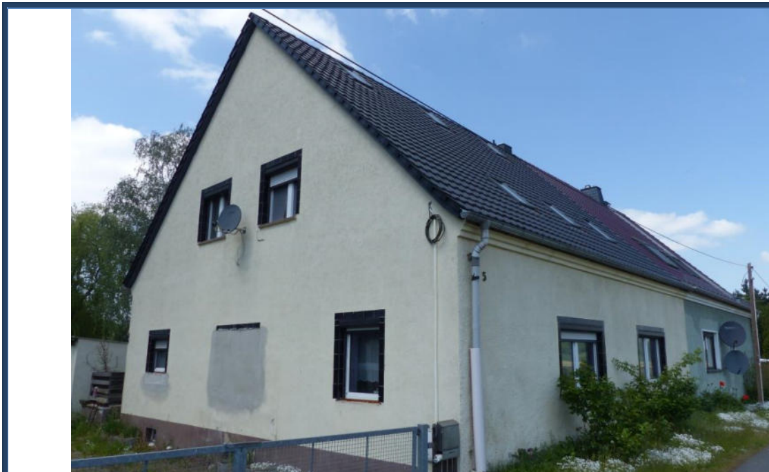
Abbildung 1: Süd-Ost-Ansicht (Vorder- und Giebelansicht); Außenanlagen; angrenzende Bebauung
