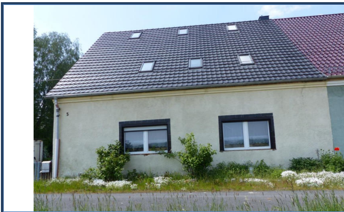
Abbildung 3: Ost-Ansicht (Straßenansicht); Außenanlagen; angrenzende Bebauung
