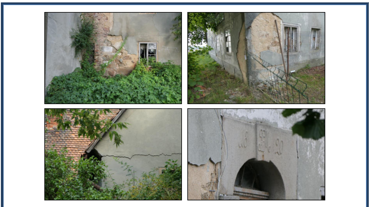
Abbildung 8: Detailansichten der Schäden an der Fassade; tlw. starke Rissbildung; überalterte und beschädigte Fenster (tlw. notgesichert)
