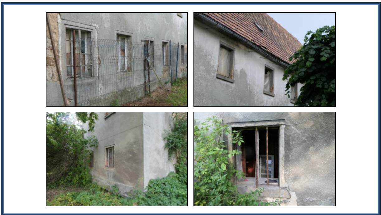
Abbildung 9: Detailansichten der Schäden an der Fassade; überalterte und beschädigte Fenster (tlw. notgesichert)
