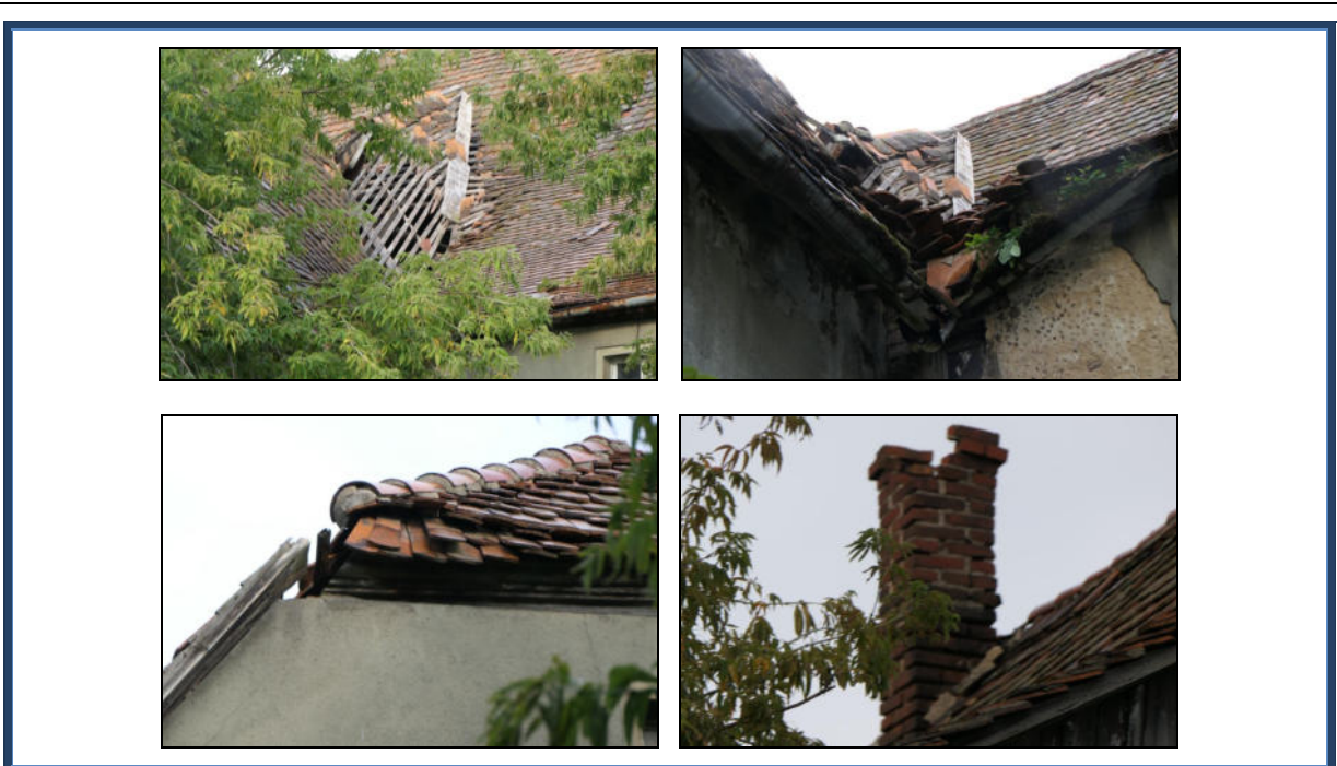
Abbildung 11: Detailansichten der Schäden an der Dacheindeckung; stark beschädigter Schornsteinkopf
