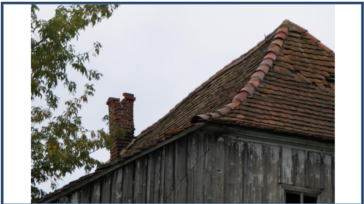
Abbildung 10: Schäden an der Dacheindeckung; stark beschädigter Schornsteinkopf
