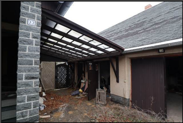
Süd-Ost-Ansicht des Nebengebäudes sowie überdachter Hofbereich
