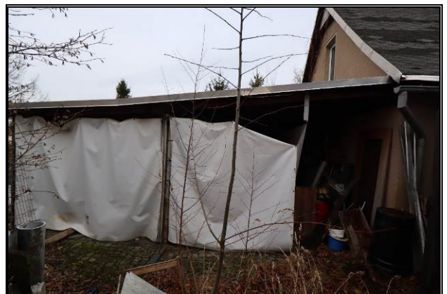
Süd-Ansicht des Anbaus am Nebengebäude (Rückbau unterstellt)
