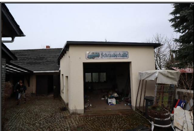
Süd-Ansicht der Hobbywerkstatt
