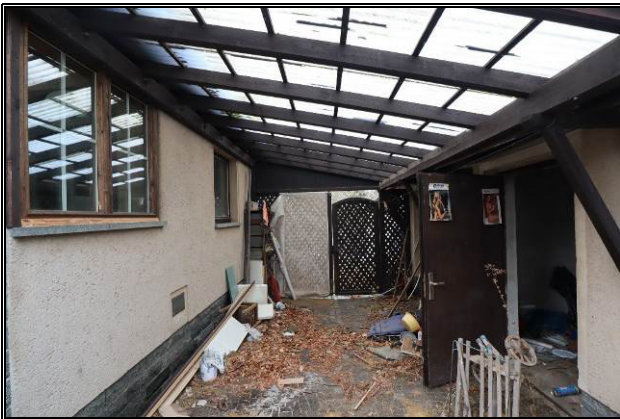
Hofbereich (Teilgrundstück 2) zwischen Wohnhaus (Überbau) und Nebengebäude
