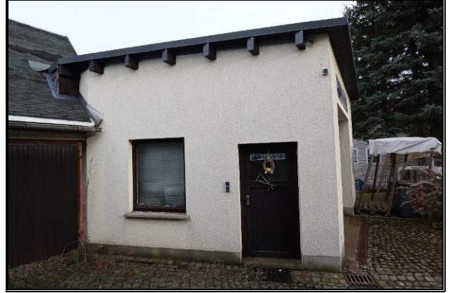
West-Ansicht der angebauten Hobbywerkstatt
