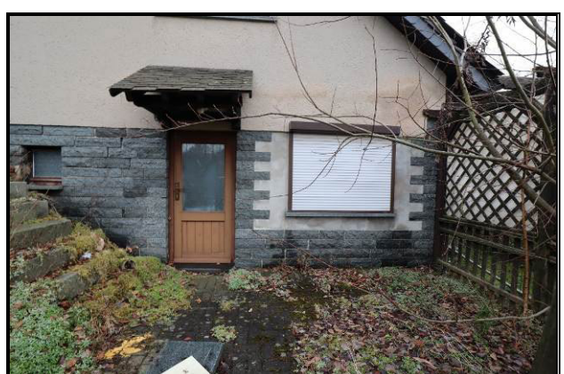
Detailansicht des Eingangsbereichs der Einliegerwohnung
