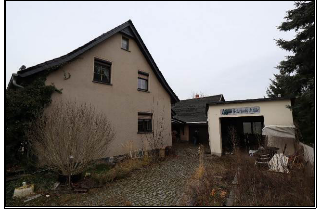
Süd-Ost-Ansicht des Wohnhauses (Teilgrundstück 1) und der Nebengebäude (Teilgrundstück 2)
