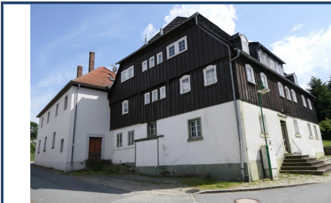
Abbildung 1: Straßenansicht (Nord-West-Ansicht); rechts das Faktorenhaus; links das Nebengebäude
