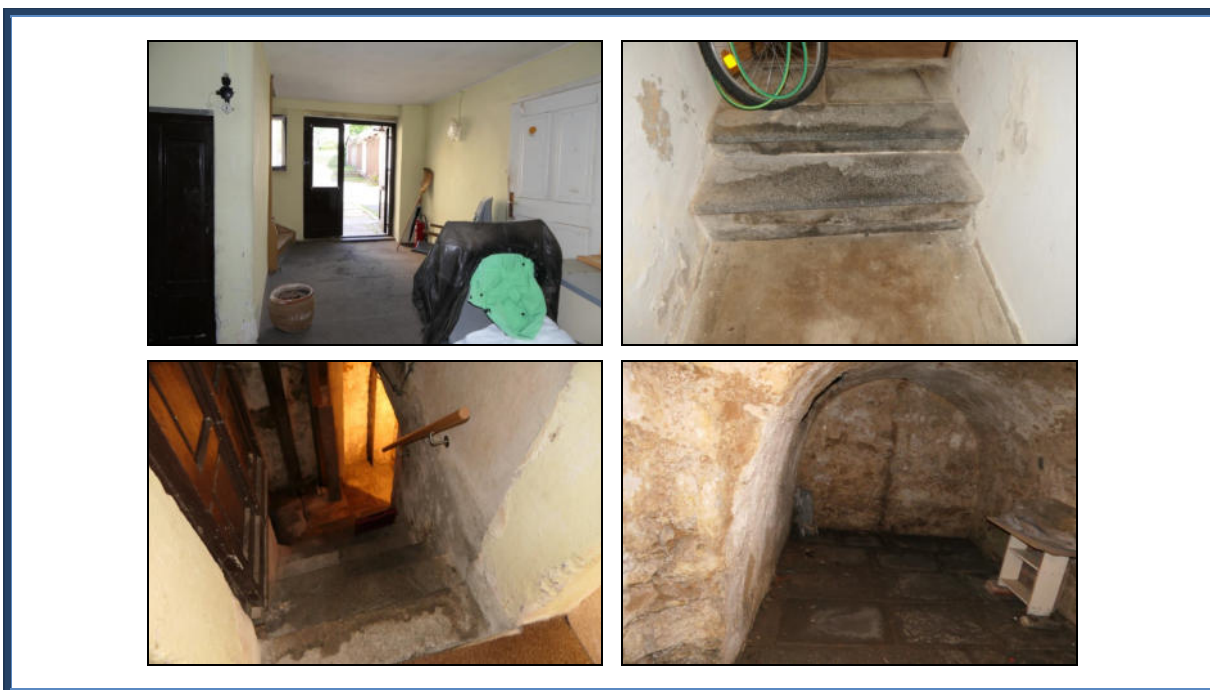
Abbildung 8: Eingangsbereich des Faktorenhauses mit Zugang zum Keller; Kellerraum
