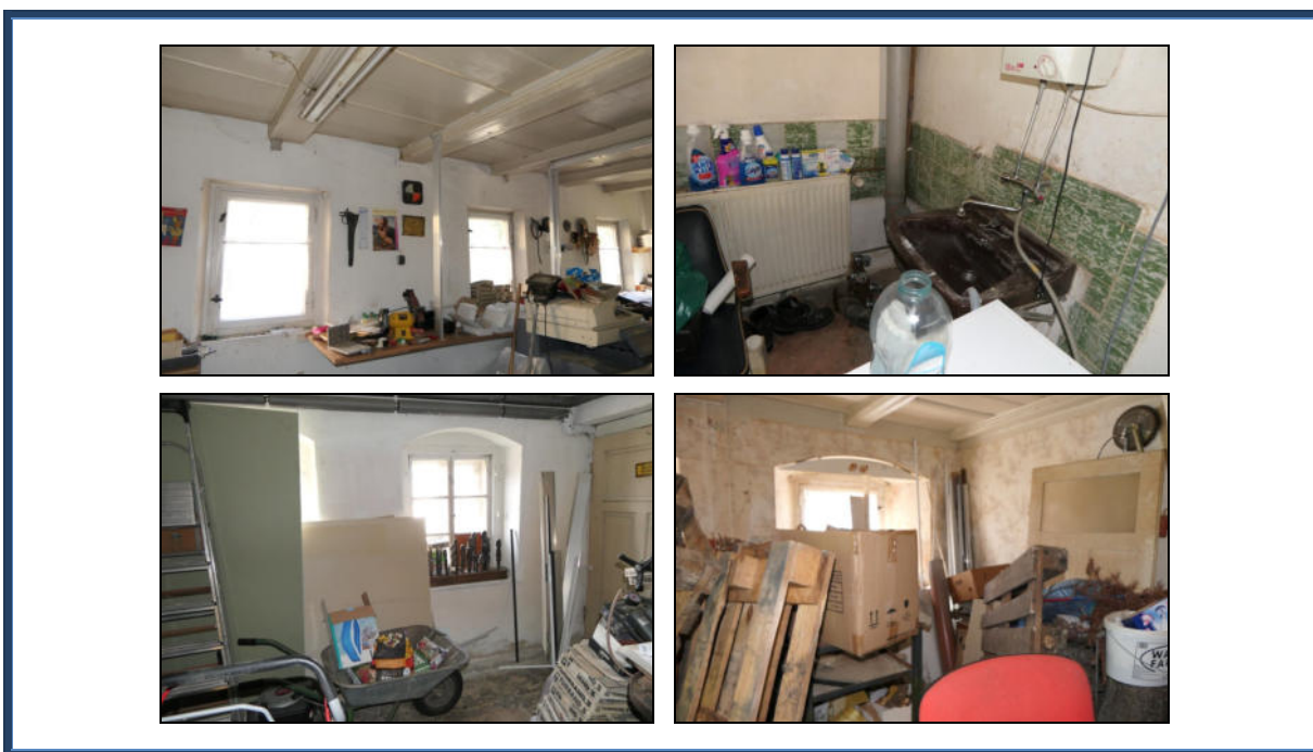
Abbildung 9: Ehemalige Gewerbe- und Lagerräume im Erdgeschoss im Faktorenhaus
