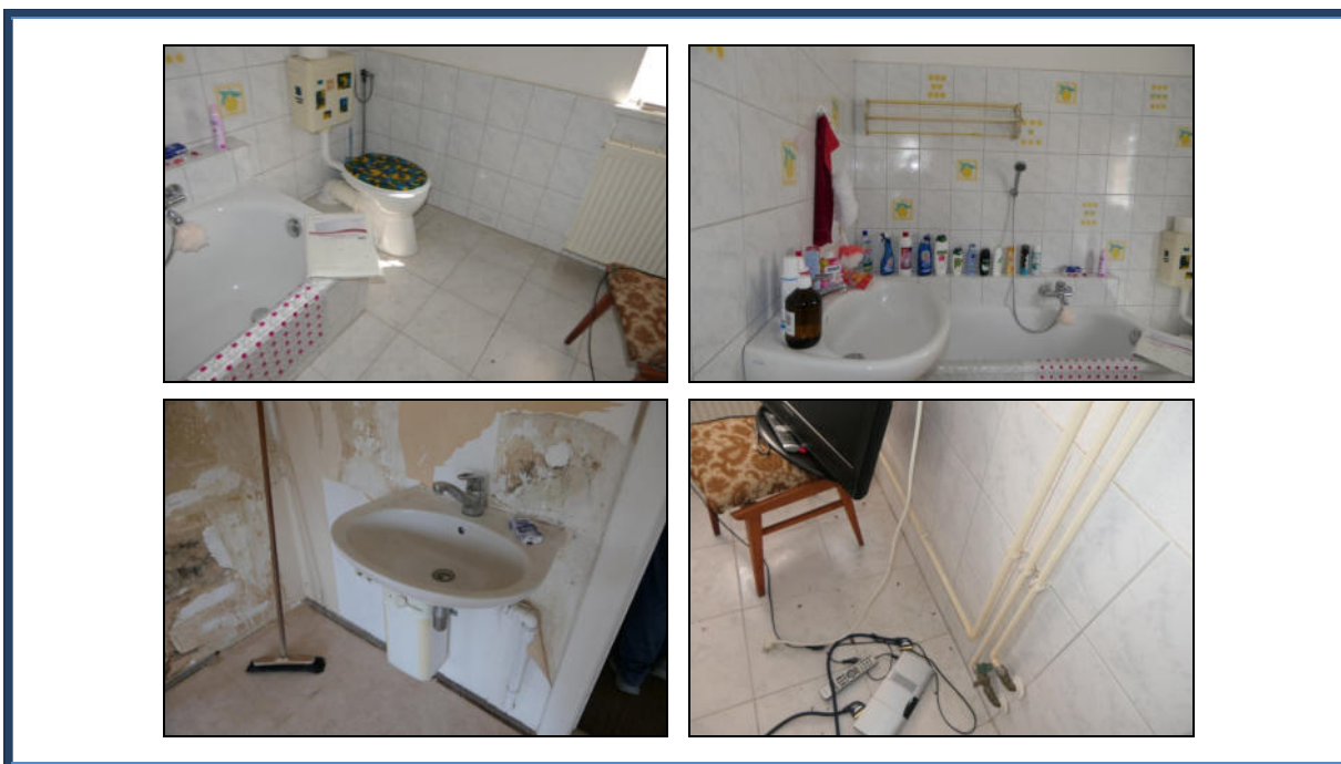
Abbildung 16: Faktorenhaus: Sanitärräume im Dachgeschoss
