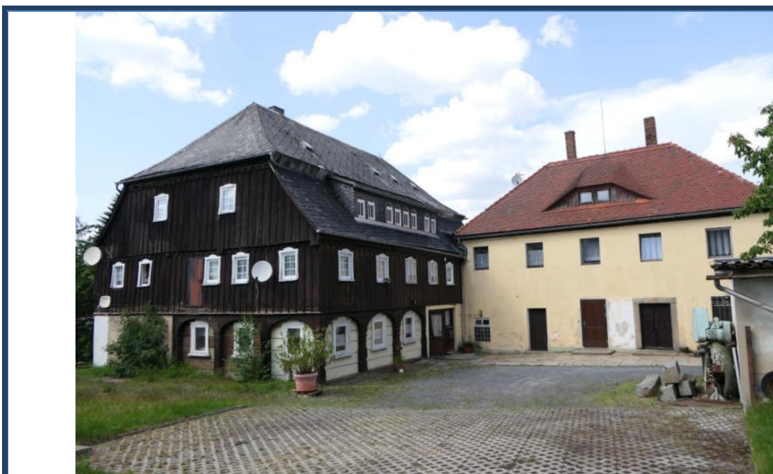
Abbildung 4: Rückansicht (Süd-Ansicht); Blick in den Innenhof; links das Faktorenhaus; rechts das Nebengebäude; Außenanlagen
