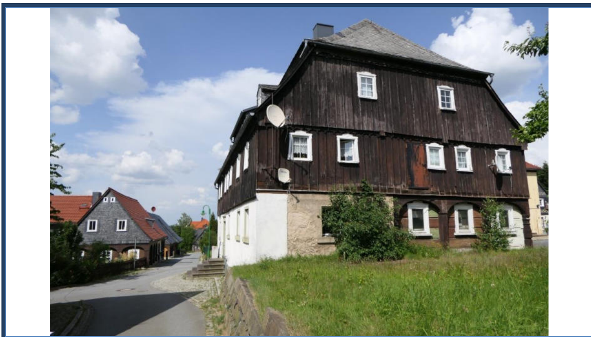
Abbildung 31: Blick in nördliche Richtung in den Rudolf-Gärtner-Weg; rechts das Bewertungsobjekt; umliegende Bebauung
