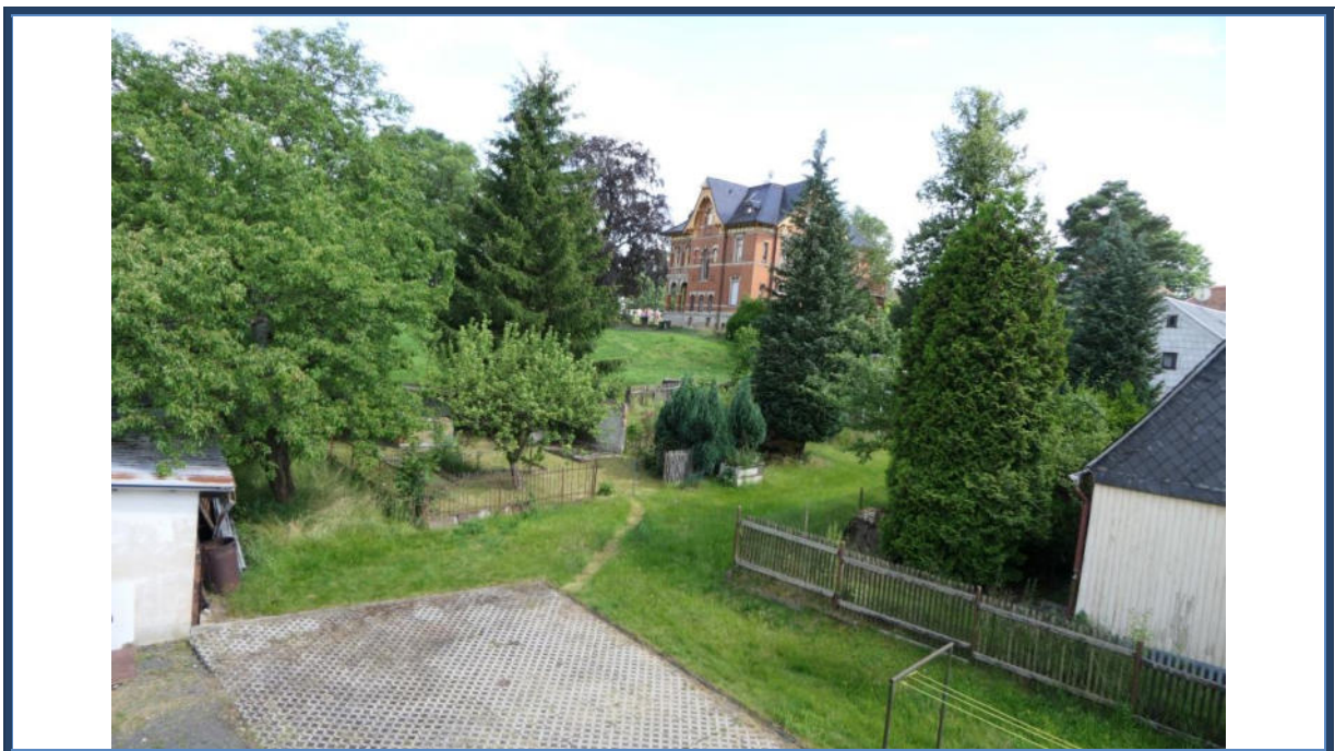
Abbildung 18: Faktorenhaus: Blick vom Dachgeschoss in südöstliche Richtung; Außenanlagen; umliegende Bebauung und Nutzung
