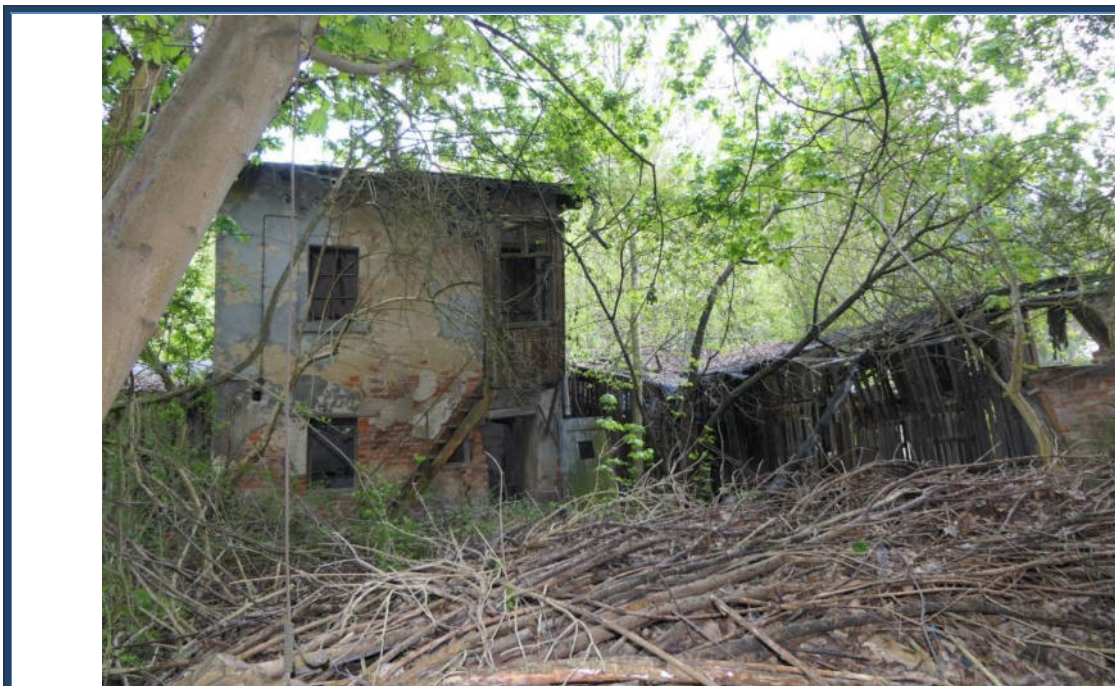
Abbildung 11: Abrissreifes massives Nebengebäude und ehemalige Schuppen im östlichen Grundstücksbereich; stark verwilderte und beschädigte Außenanlagen
