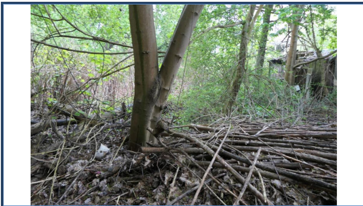
Abbildung 14: Stark verwilderte und beschädigte Außenanlagen im nordöstlichen Grundstücksbereich
