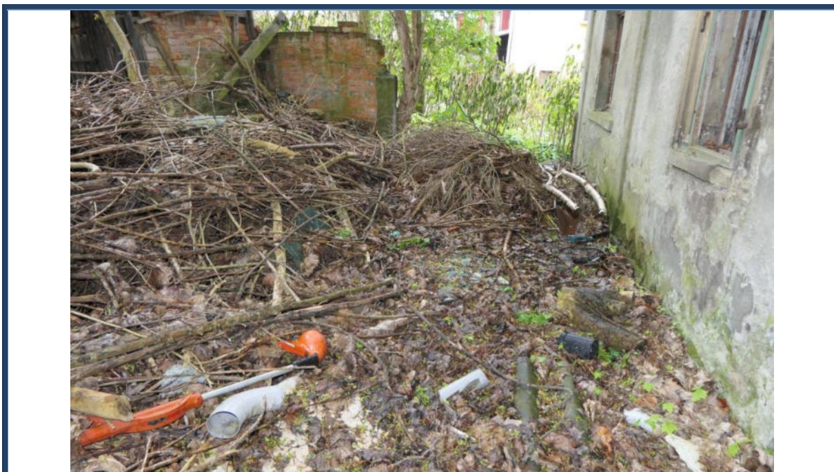
Abbildung 16: Stark verwilderte und beschädigte Außenanlagen im rückseitigen Grundstücksbereich
