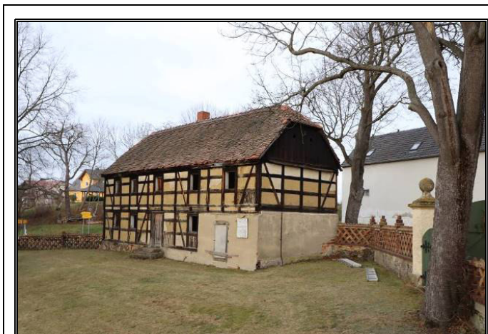
Süd-Ost-Ansicht des Fachwerkhouses
