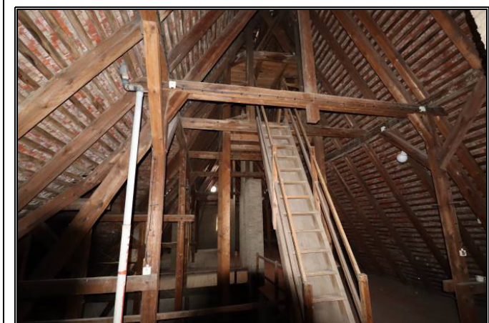
Teil des Dachbodens
