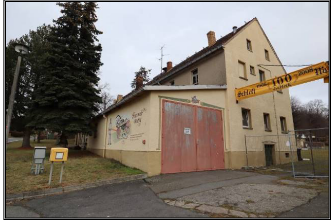
Süd-West-Ansicht des Gemeindehauses mit Feuerwehrgarage
