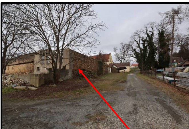
Süd-Ost-Ansicht der ehem. Scheune
