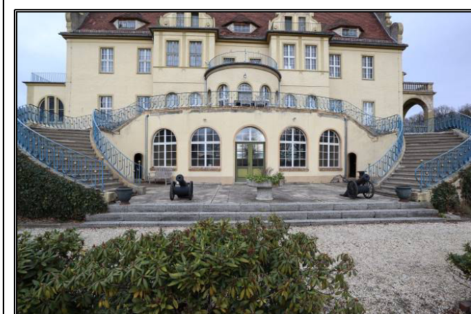
Detailansicht der Freitreppe (Süd-Ansicht)
