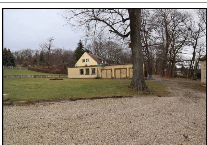
West-Ansicht des Lagergebäudes
