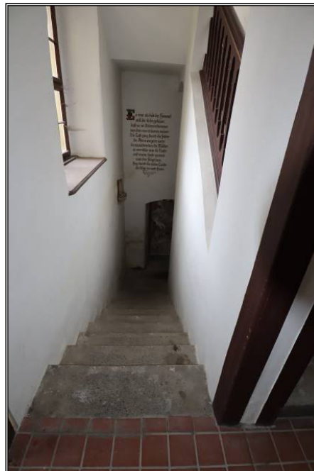
Treppe zum Kellergeschoss
