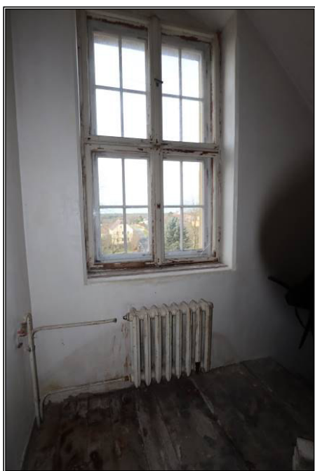
Teil des Treppenhauses im Westflügel des Schlosses
