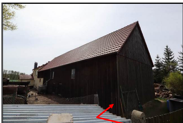
Nord-Ost-Ansicht der Scheune; Bereich des Überbaus
