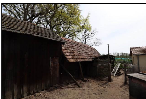
Nord-West-Ansicht des abrisstauglichen Schuppenensembles
