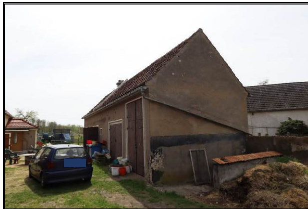
Nord-Ost-Ansicht des Nebengebäudes
