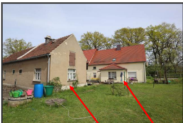
Süd-West-Ansicht: Nebengebäude und Wohnhaus
