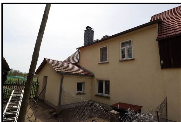
Nord-Ost-Ansicht des Wohnhauses mit rückseitigem Anbau
