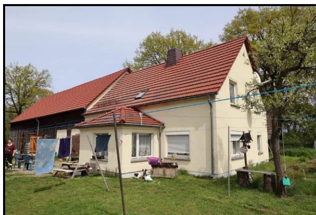
Süd-West-Ansicht des Wohnhauses mit angegliedertem Stall-/Scheunenbereich
