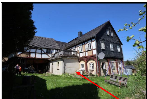
Süd-Ost-Ansicht des Wohnhauses mit Bad- und Eingangsanbau
