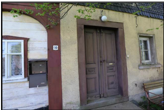
Detailansicht des Eingangsbereiches (straßenseitig)
