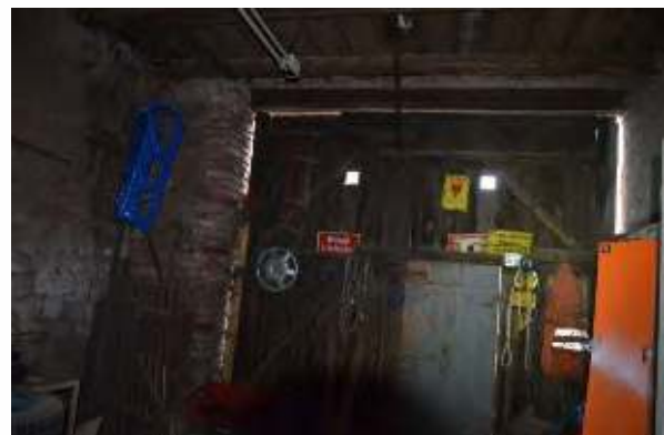
Innenansicht Scheune (Garagennutzung)
