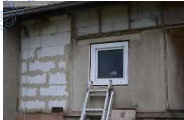
Fenster im Bad EG
