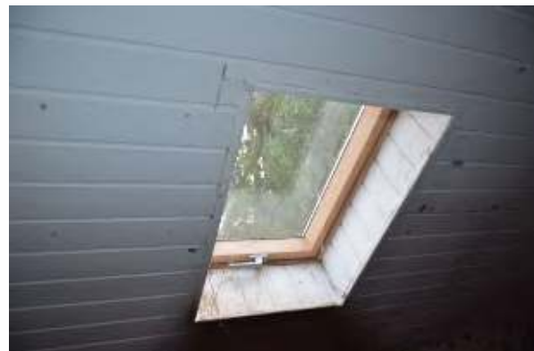
Dachflächenfenster und Deckenbekleidung
