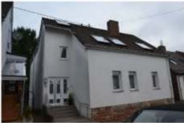
Straßenansicht mit Anbau (links)
