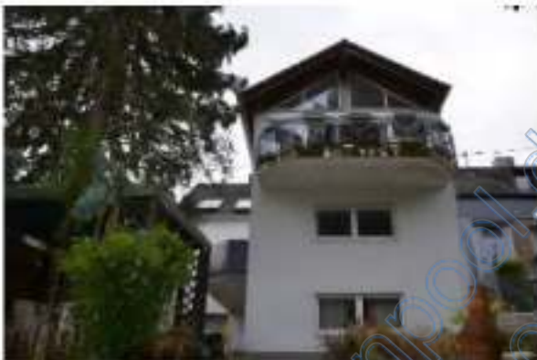
Rückansicht mit Anbau
