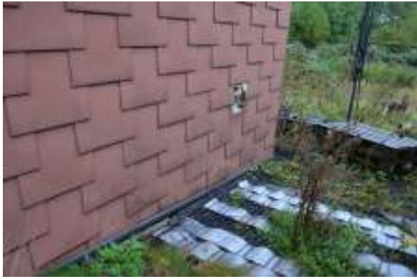
schadhafte Faserzementplatte
