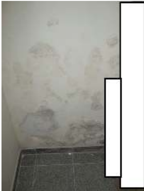
Ausschnitt Feuchtigkeitserscheinungen Sauna-/Kellerraum
