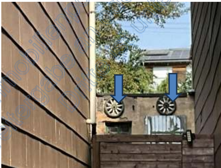
Nebengebäude im Außenbereich, hier Ostgrenze
