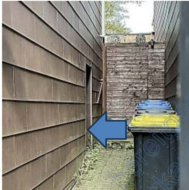
2. Zugang zum KG, unterstellter Kellerzugang
