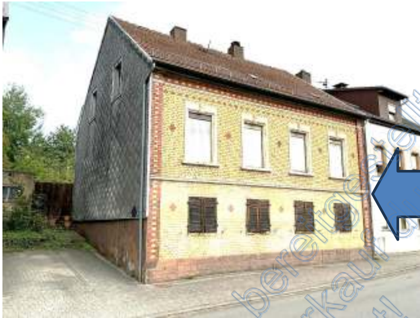
Ansicht Süd mit PKW-Stellplatz vor Westgiebel
