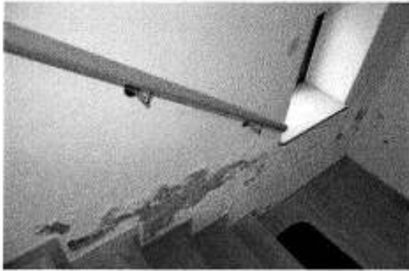
Kellertreppenabgang – Putz- und Feuchtigkeitsschäden
