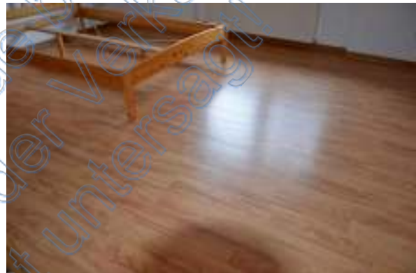
Bodenbelag im EG exemplarisch
