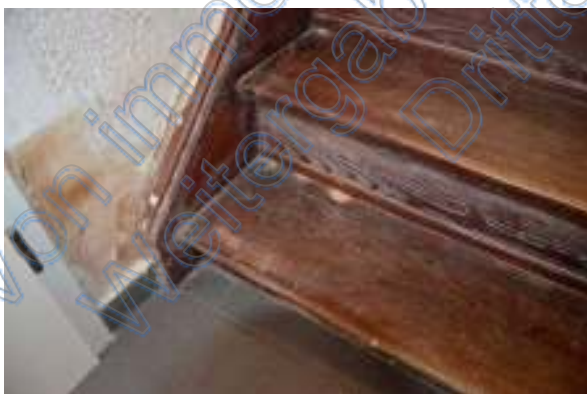
Geschosstreppe mit Schädlingsbefall und Feuchtigkeitsschäden
