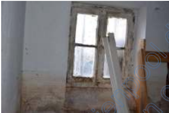
Putz- und Feuchtigkeitsschäden im Keller des Nebengebäudes
