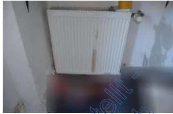
Putz- und Feuchtigkeitsschaden im EG, korrodierter Heizkörper
