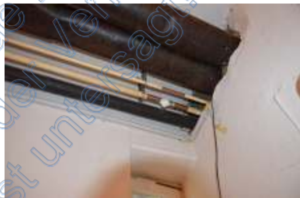
korrodierte Wasserleitung
