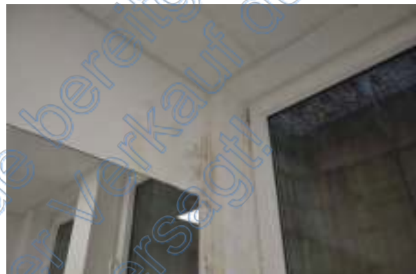
Schimmelbildung in Damen-WC der Gewerbeeinheit
