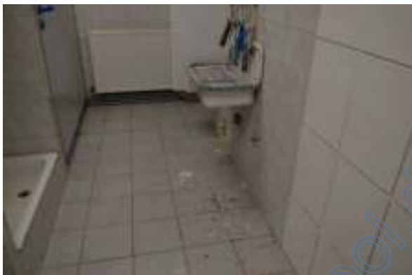
Fliesenspiegel in Herren-WC der Gewerbeeinheit nicht verfugt
