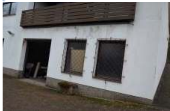
Fassade WUG verfärbt, verschmutzt teilweise schadhaf
