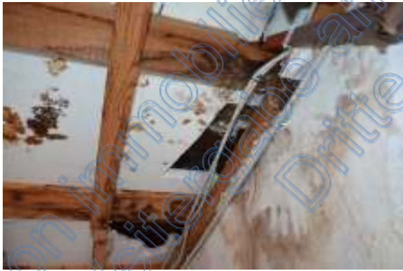
fehlende Deckeninnenbekleidung, Feuchtigkeitsschaden aufgrund schadhafter Dacheindeckung an Garage
