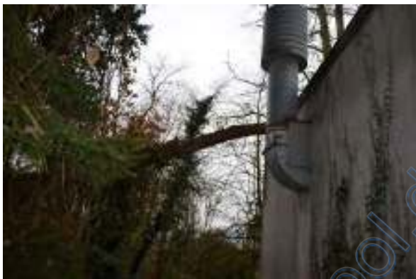
Rückseite Lagergebäude, Fassade verfärbt und verschmutzt, umgestürzter Baum auf Lagergebäude
