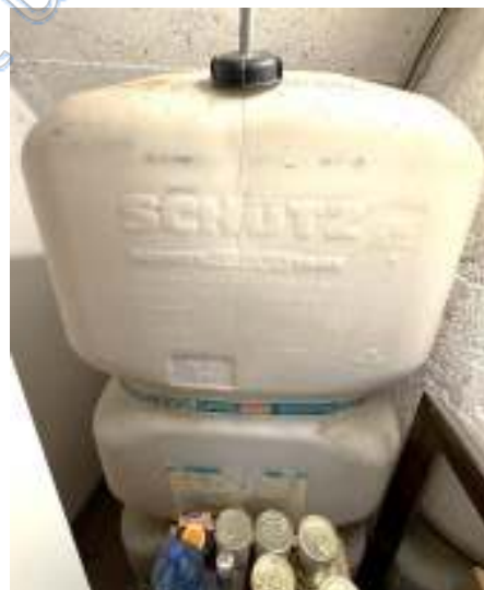
Kunststoff-Öltank in KG-Garage
